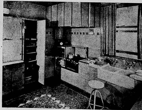
Nesta cosinha, ha a suppressão completa dos pés dos moveis. Fogão, pias, mezas, tudo isso é feito nas paredes e coberto de tijolos. O buffet laqué e cromado, assenta no chão. Resultado: grande facilidade de limpeza. A pia recebe luz directa de uma janella basculante. A notar sobre o fogão, um registrador de minutos.
