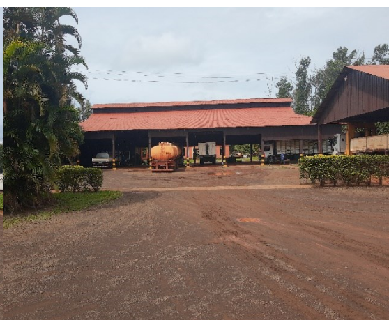
Figura 46: Atual garagem (antiga área de processamento da erva mate). Fonte: Fazenda Campanário, 2023.
