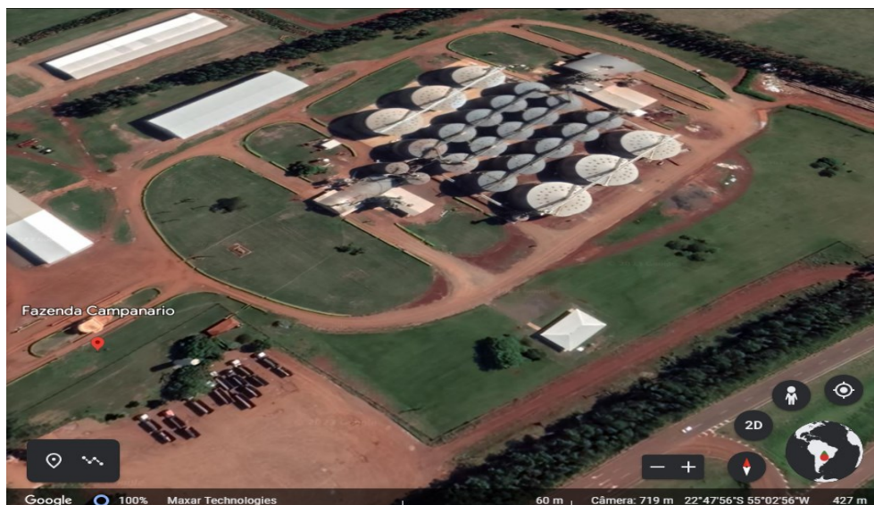
Figura 51: Silos de estocagem dos grãos na Fazenda Campanário. Fonte: Google Earth, 2023.
