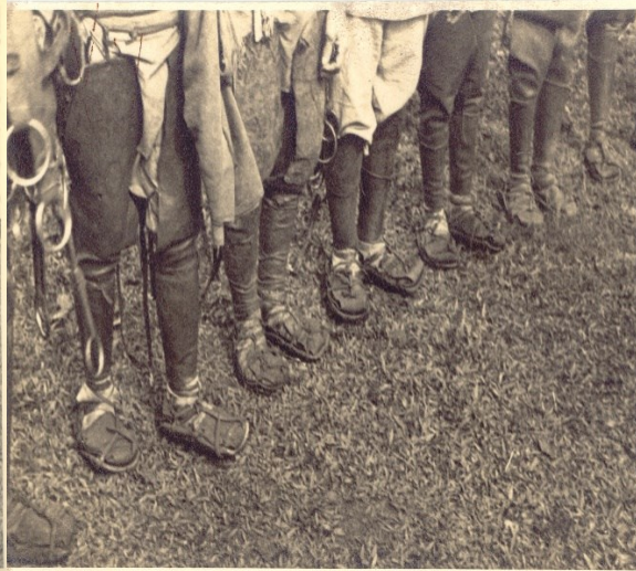
Figura 39: Detalhe da proteção dos pés dos trabalhadores. Fonte: CDR, 2023.
