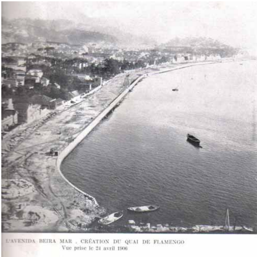
Avenida Beira Mar em 1906, trecho do Flamengo até o Morro da Viúva
