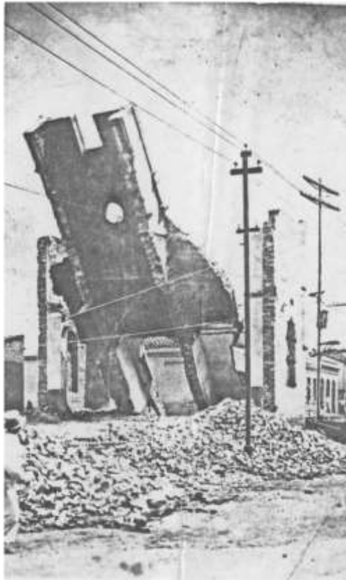
Imagem 17 – Demolição da capela da Vila Arens em 1937 (Arquivo Histórico de Jundiaí)
