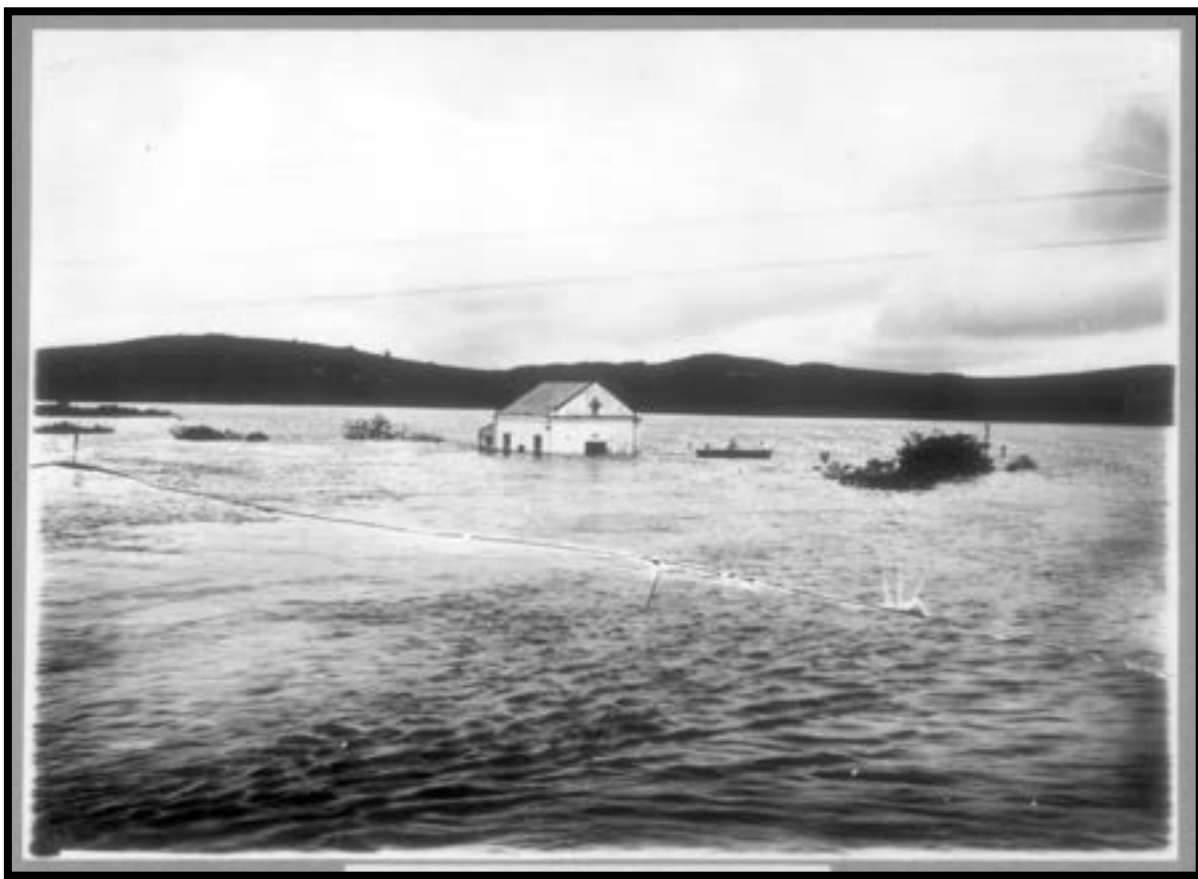
20. Área alagada na confluência dos rios Tietê e Pinheiros. Ao centro da imagem, casa das máquinas do Frigorífico Wilson. Fonte: Fundação Energia e Saneamento.
