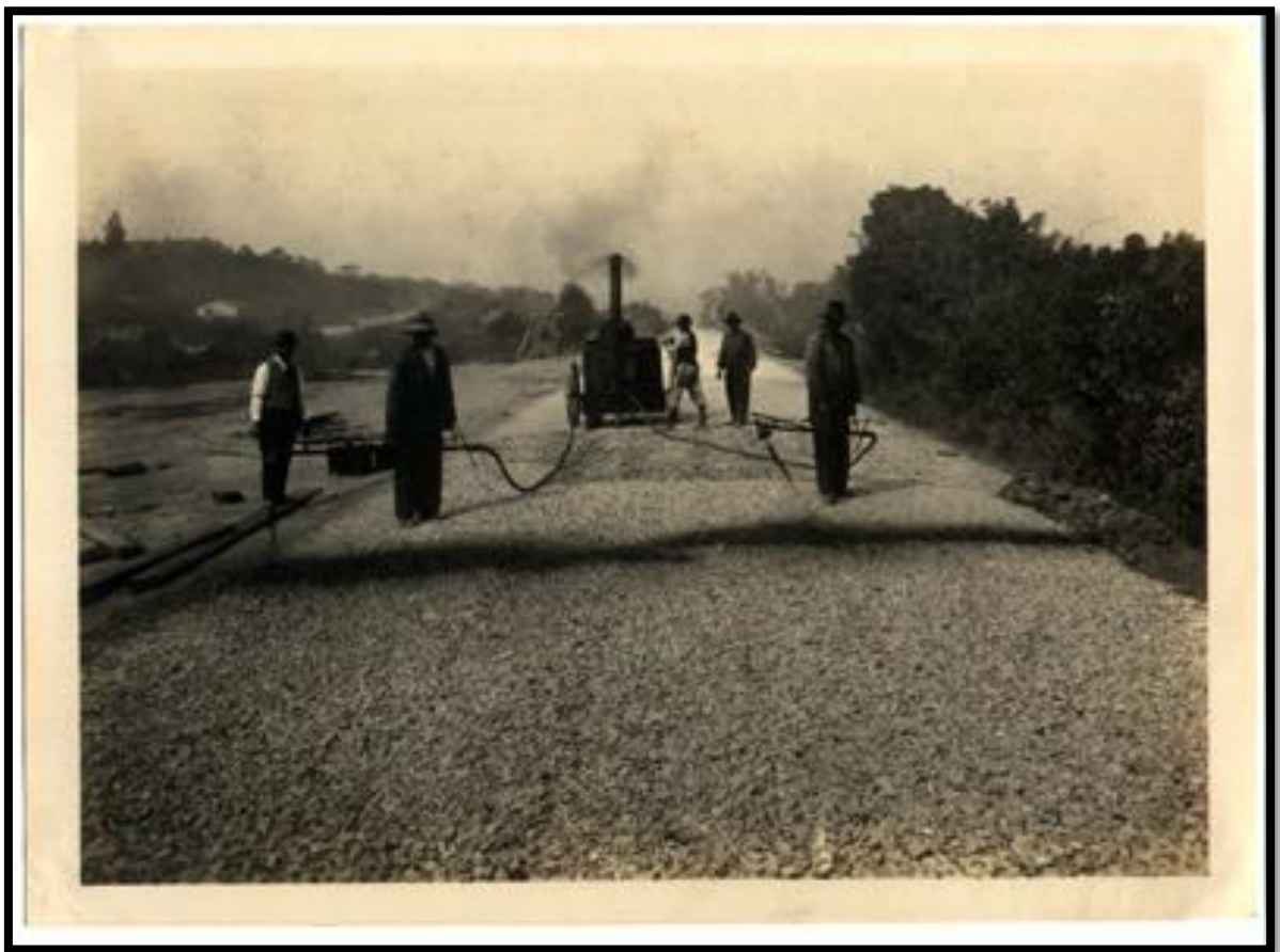
15. Obra de pavimentação da Estrada de Ytu, entre São Paulo e Osasco (atual Avenida Corifeu de Azevedo Marques). Fonte: Acervo Fotográfico Arquivo Histórico de São Paulo. 21 out. 1927 – PMSP – Autor desconhecido – Nº 2.043.
