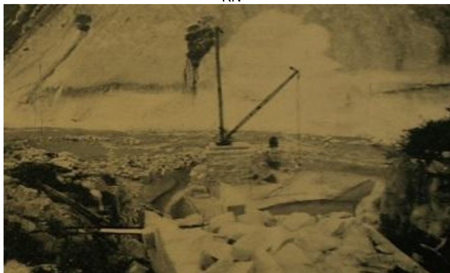
Figura 43: um guindaste para represamento do rio Acauã e construção do açude de gargalheiras – Acari-RN
