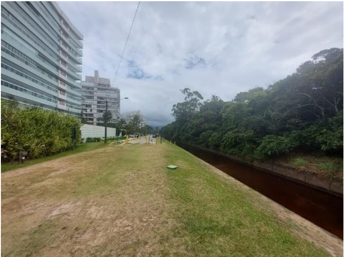
Figura 28 – Canal de drenagem como delimitador territorial, janeiro de 2023
