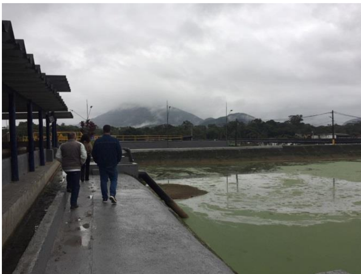
Figura 25 – Estação de Tratamento de Esgoto da Riviera, dezembro de 2021
