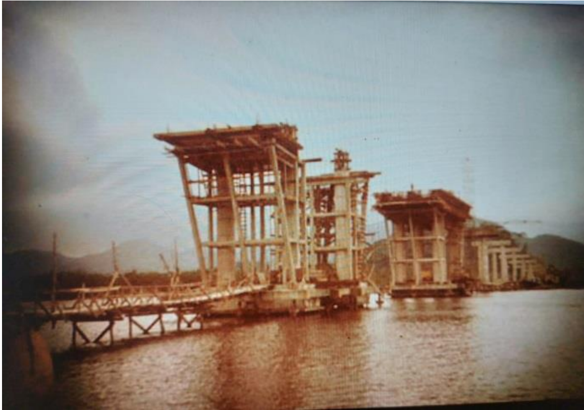
Figura 3 – Construção da ponte sobre o rio Itapanhaú em 1981
