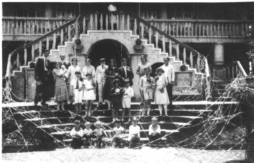
Foto 2 - Reforma da residência da Fazenda Ibicaba, de propriedade da família Levy.
