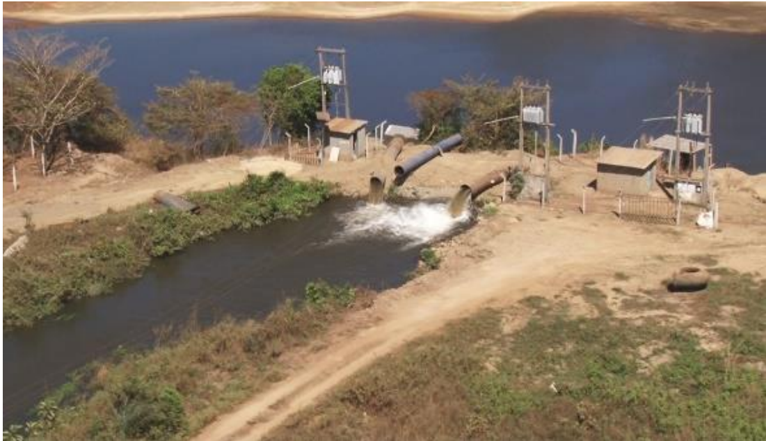
Figura 2: Captação Irregular de água no/do Rio Formoso
