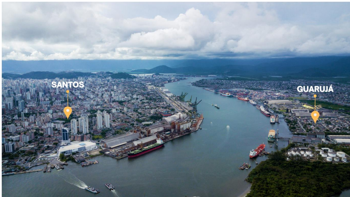
Figura 22 – Vista aérea do canal do Porto de Santos
