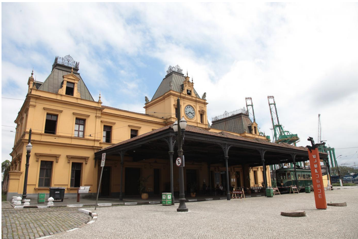
Figura 10 – Estação Ferroviária do Valongo
