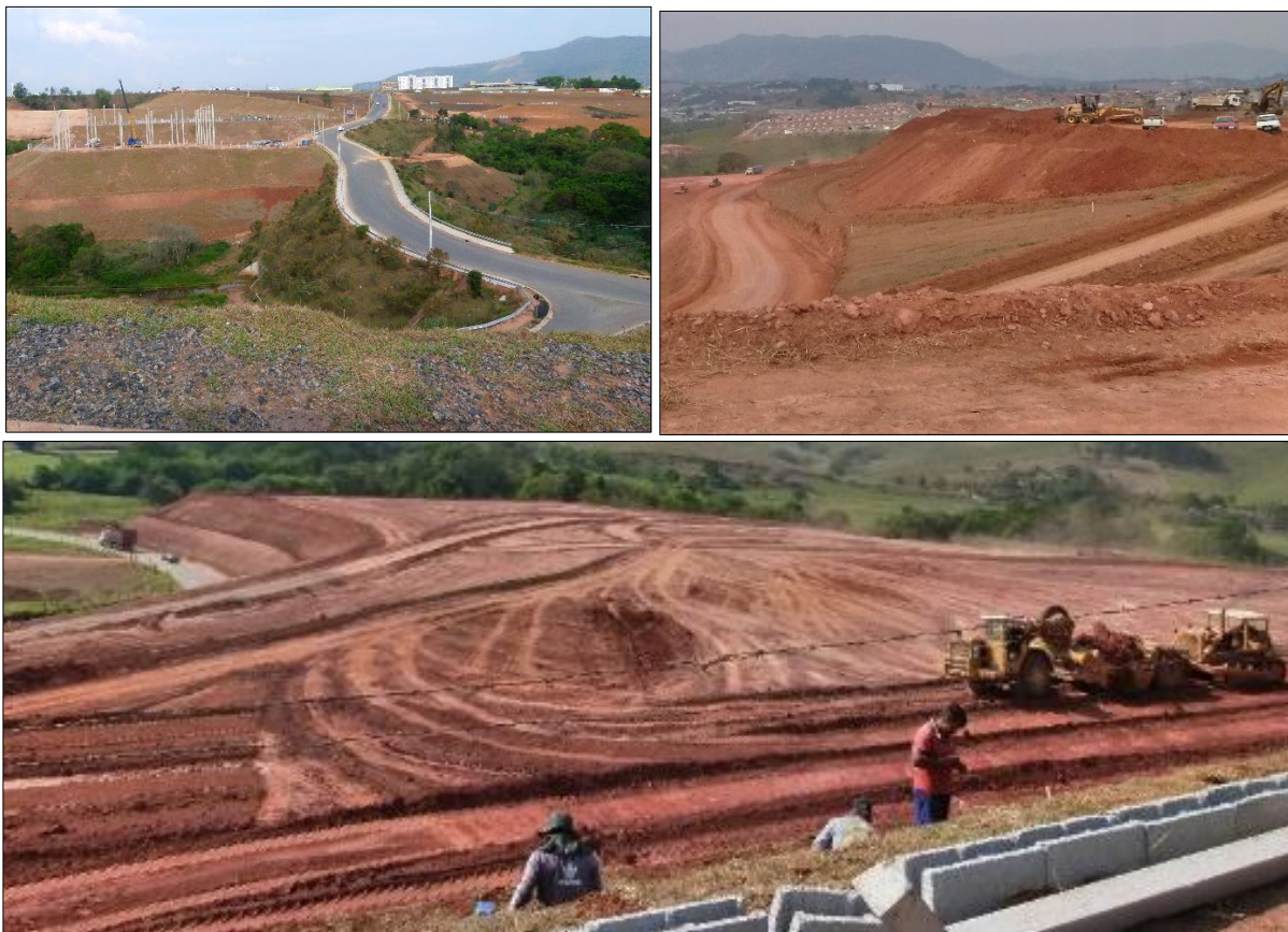
Figura 32 - Etapa de terraplanagem para construção de novos centros de distribuição
