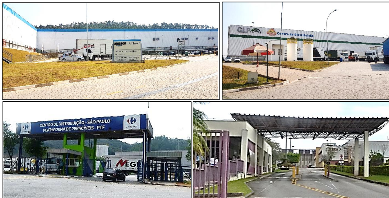
Figura 1 - Fachadas de centros de distribuição
