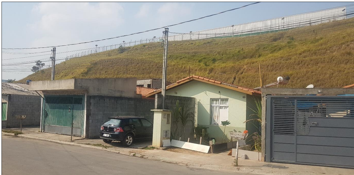
Figura 37 - Cajamar: conjunto habitacional Cimiga I e centro de distribuição do Mercado Livre (2022)
