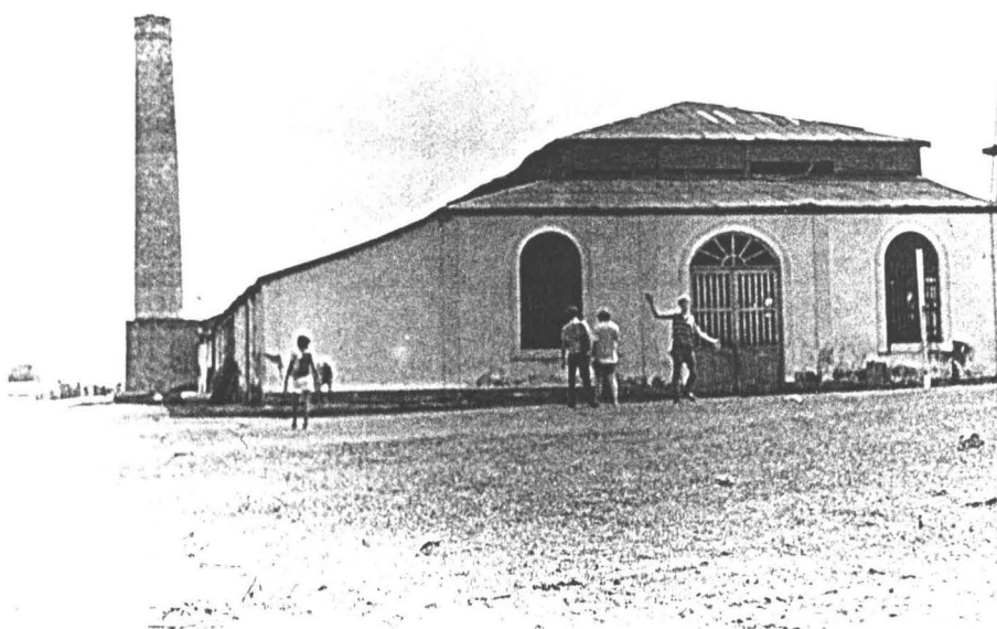
Fachada frontal da Charqueada
