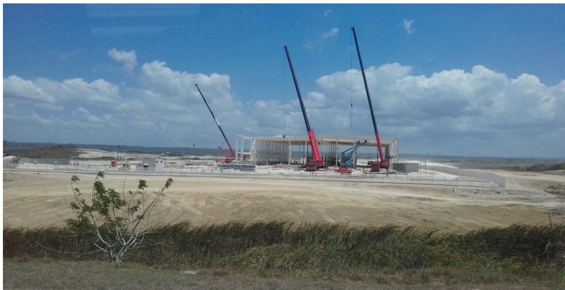
Foto 21: Empresa em construção na ZED Mariel. Por Ana Sylvania Maris Ribeiro, maio de 2019.
