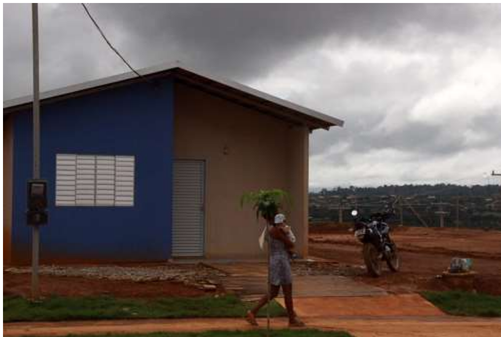
Fotos de construção dos RUCs. Fonte: Lizardo, 2015.
