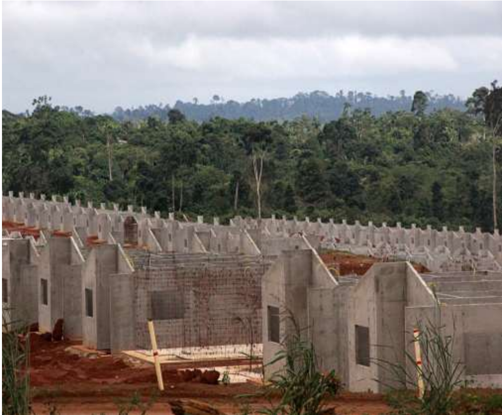
Casas do Ruc sendo construídas. Fonte: Lizardo, 2016.
