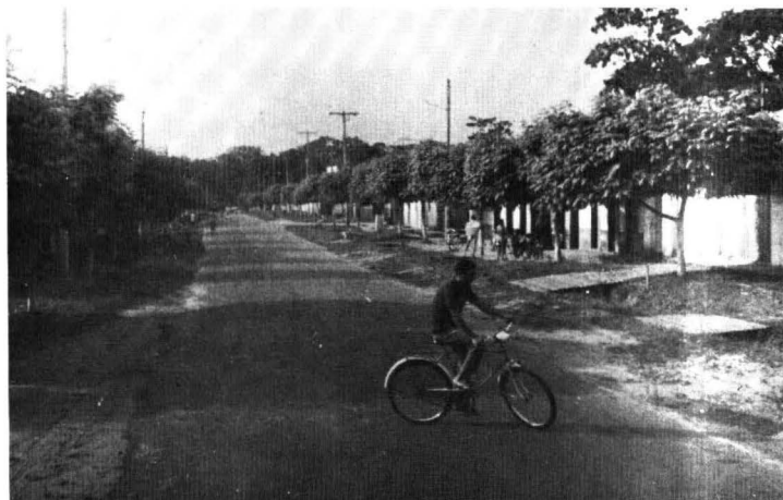
Foto 26- Rua principal da cidade de Santo Antônio do Tauã - observe-se a topografia plana de seu sítio e a concentração do comércio (foto da autora, 1972).
