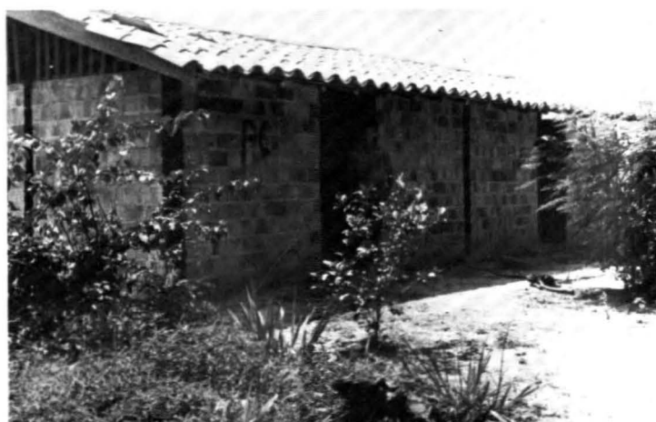
foto 41- Casa de assalariados-novo elemen- to do habitat em Santo Antônio do Tauã, característico em pimentais de japoneses (foto da autora , 1972).
