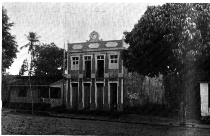
Foto 23 - Construção colonial, na Praça da Matriz, contrastando com as demais construções - P. Salvo (foto da autora, 1972).
