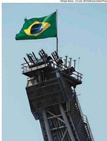
Plataforma da Petrobras em construção em Angra dos Reis
