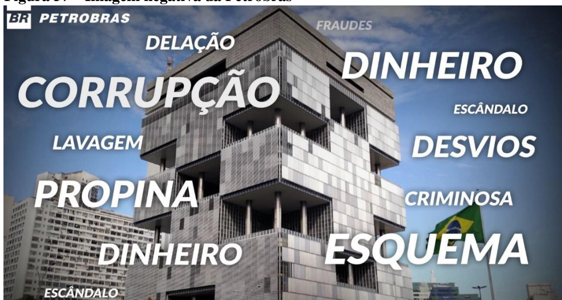
Figura 57 – Imagem negativa da Petrobras
