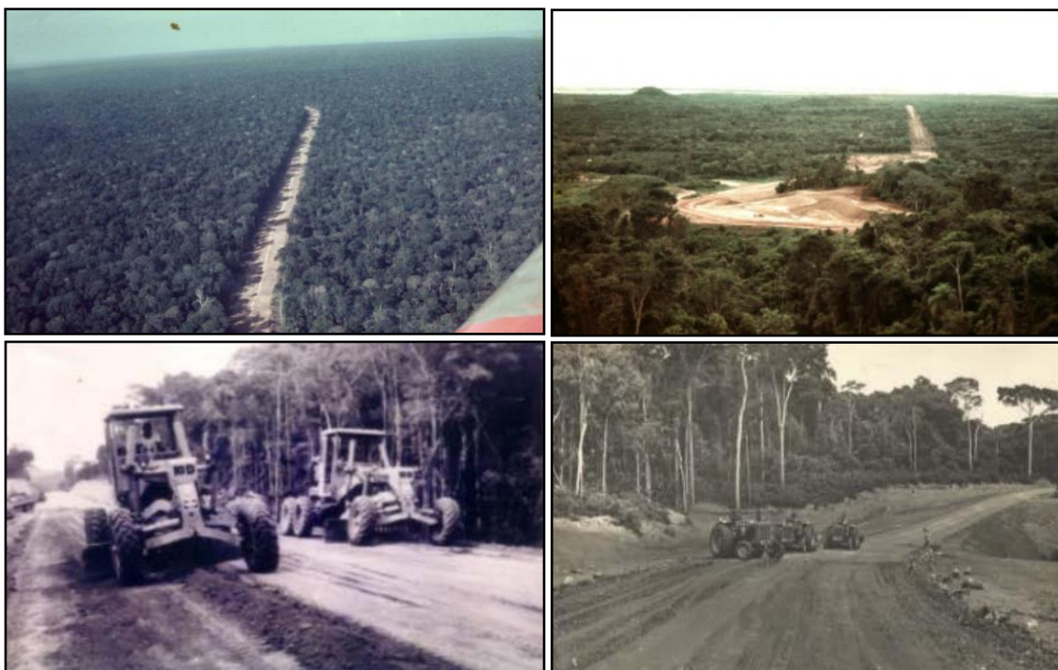
Figura 25 - Início das obras de abertura da BR-163 em 1970
