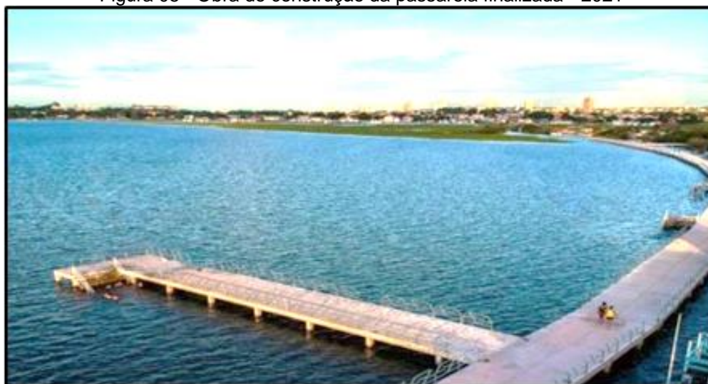
Figura 05 - Obra de construção da passarela finalizada - 2021
