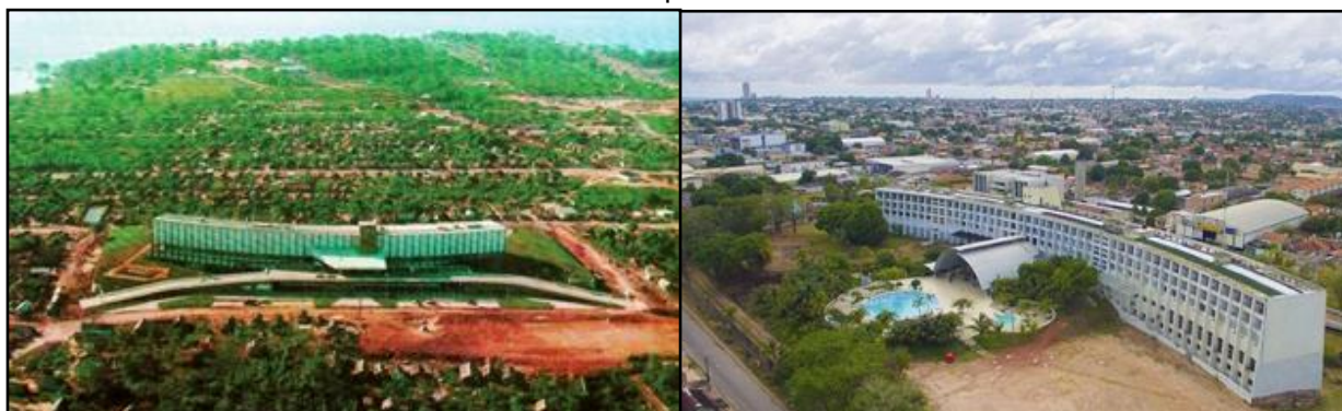
FIGURA 09 - Barrudada Tropical Hotel de Santarém - PA
