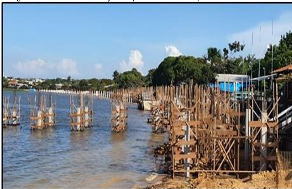
Figura 04 - Obra de construção da passarela sobre a praia do Maracanã - 2020
