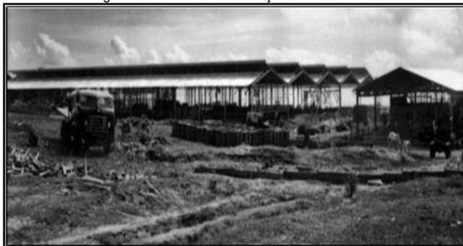
Figura 22 - Obras de construção da TECEJUTA
