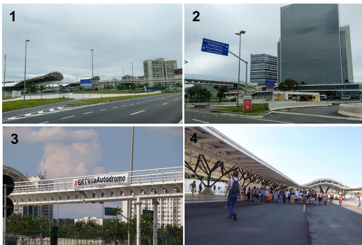
Figura 45 – BRT Trans Olímpica – Estação Parque Olímpico
