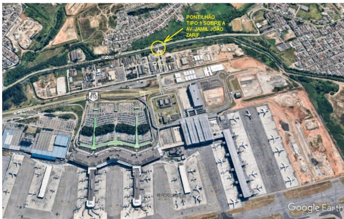
FIGURA 28 - PONTILHÃO SOBRE A AVENIDA JAMIL JOÃO ZARIF
