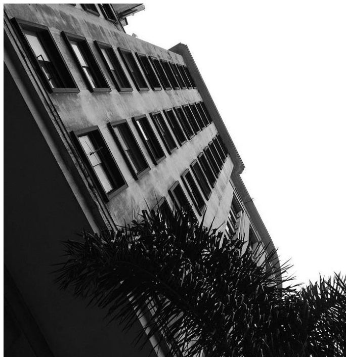
Figura 97: Parte externa da ocupação Cambrigde na avenida Nove de Julho. Fonte: produção própria, 24 ago. 2017
