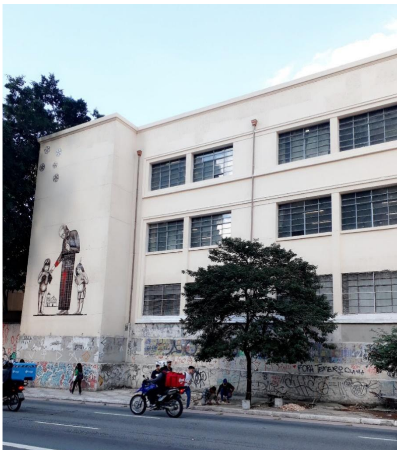
Figura 1: Escola Estadual Marina Cintra vista da Rua da Consolação. Fonte: produção própria, 29 mai. 2019.
