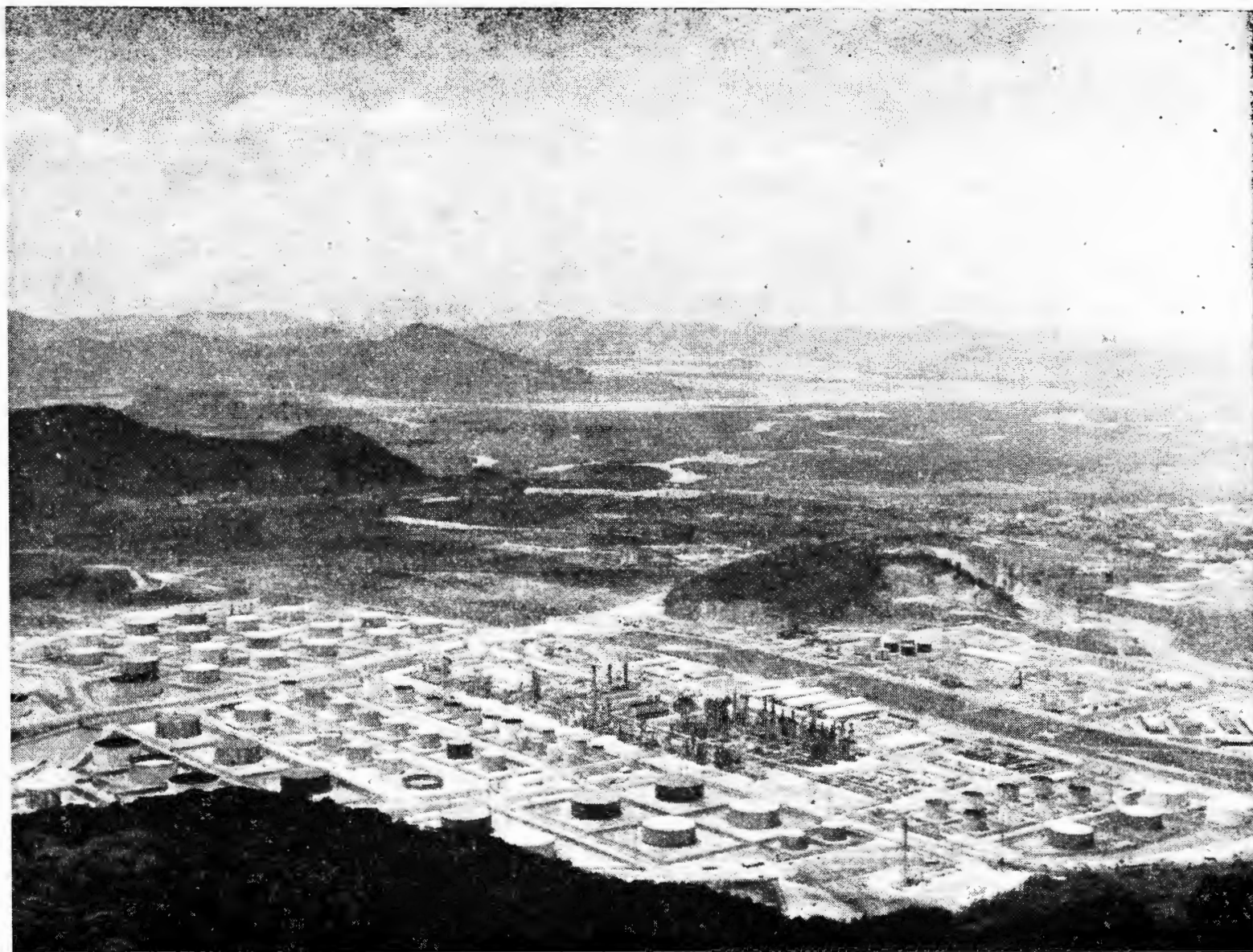
Vista tirada da baixa encosta em direção ao canal do estuário. Em primeiro plano estão as instalações industriais da Refinaria e os seus depósitos. À margem direita do rio Cubatão fica o aglomerado urbano, seguido pela vasta área pantanosa que separa a cidade do braço de mar que conduz a Piaçaguera (COSIPA). No fundo, á direita, vê-se Santos.
