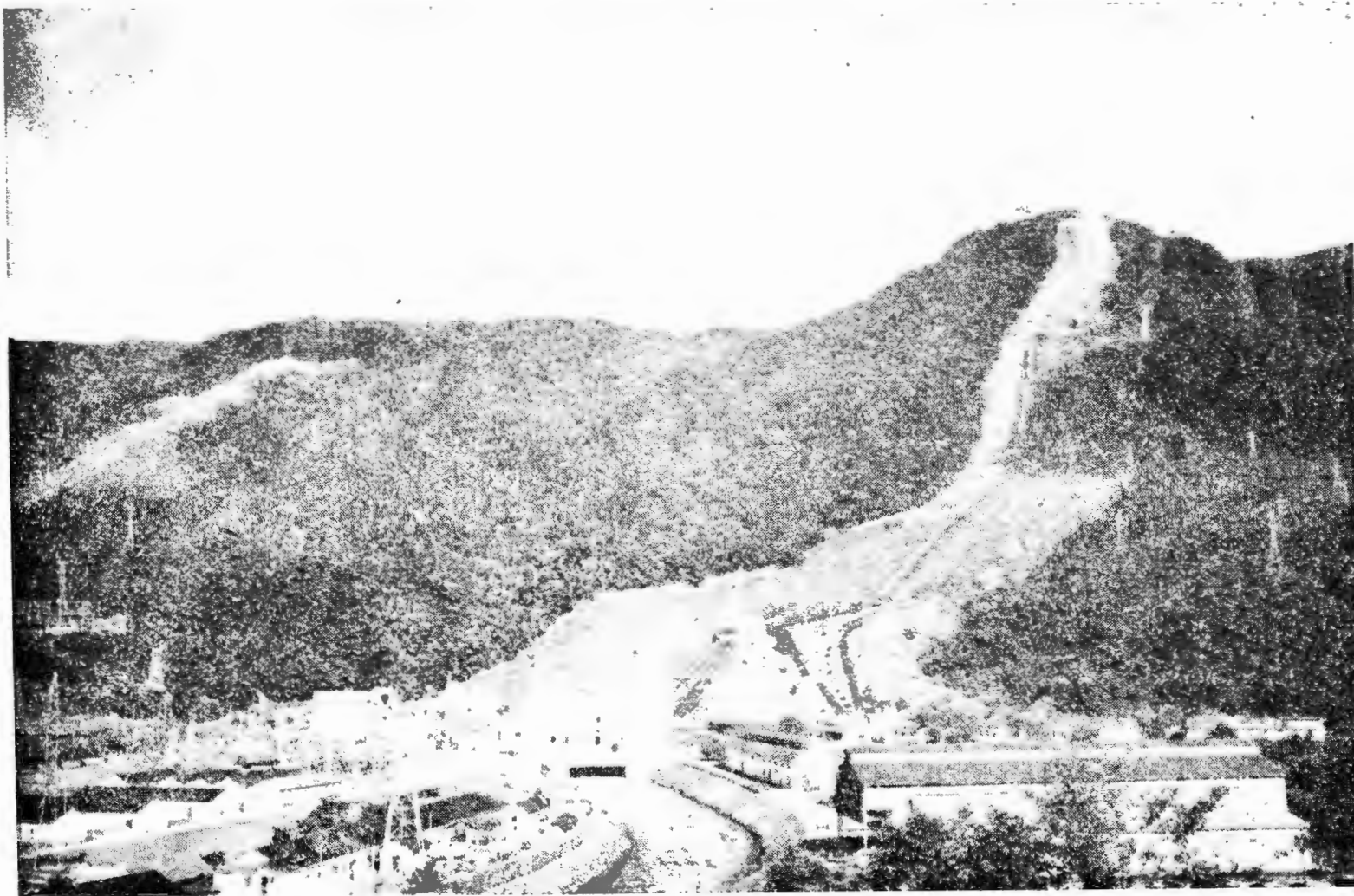
As instalações da Light na raiz da serra, vendo-se as tubulações que trazem a água.
