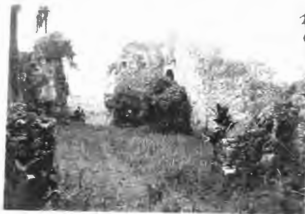
Foto 38. O que resta da primitiva igreja e convento construídos em meados do século XVI pelos jesuítas na praia de Peruibe, no local onde os portugueses martin-afonsinos principiaram a colonização da região itanhaense. Estes restos de paredes invadidos pelo mato são conhecidas por "Ruínas do Abarebebê". (foto do autor).
