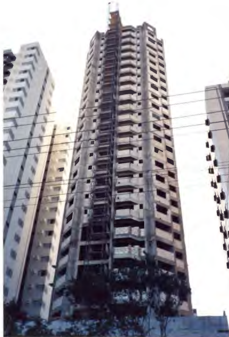
Foto 34: Edifício Eduardo Froes da Motta, Zona 1.
