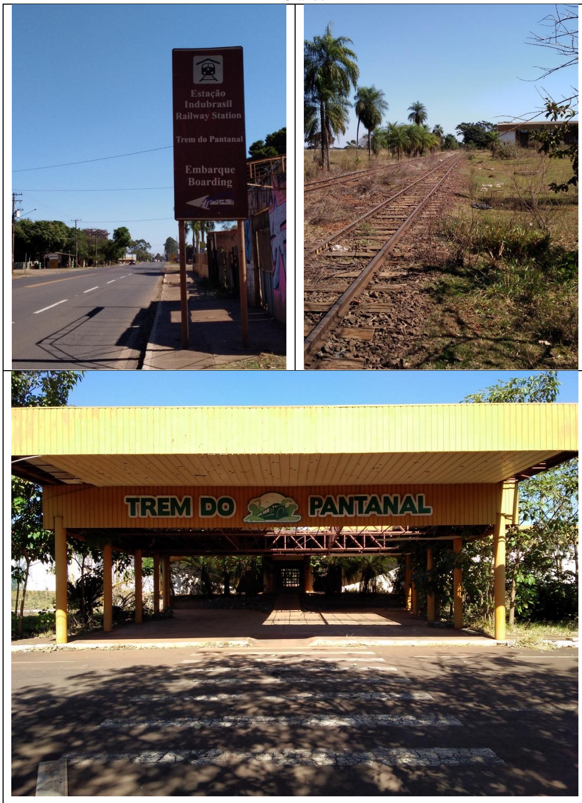
Figura 45. Acesso e instalações da Estação Ferroviária Indubrasil – Trem do Pantanal em Campo Grande
