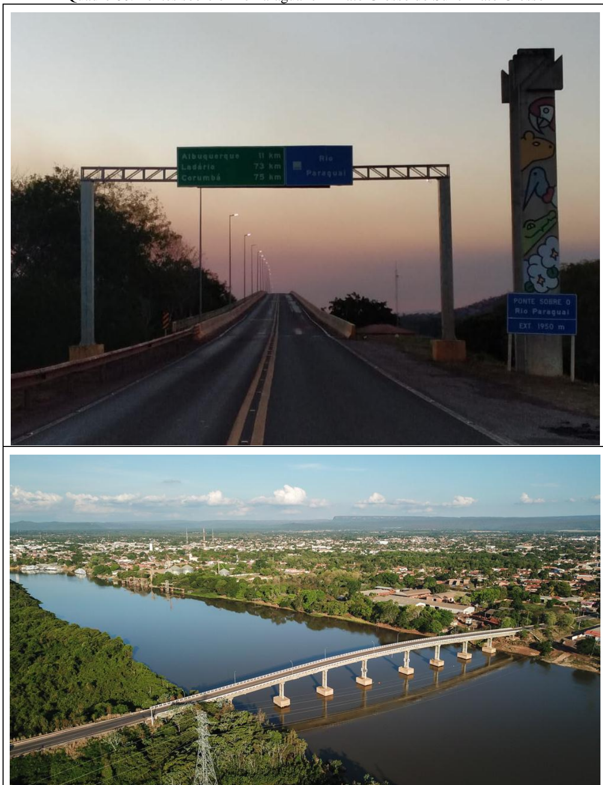
Quadro 80. Pontes sobre o Rio Paraguai em Mato Grosso do Sul e Mato Grosso
