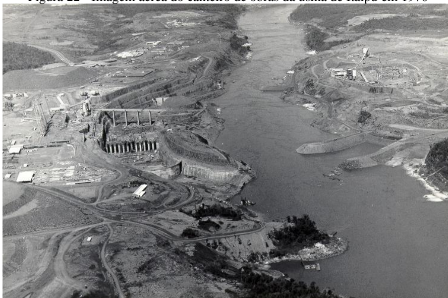
Figura 22 - Imagem aérea do canteiro de obras da usina de Itaipu em 1970
