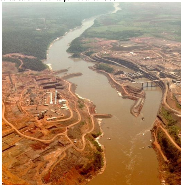
Figura 21 - Imagem aérea da movimentação no canteiro de obras da usina de Itaipu nos anos 1970
