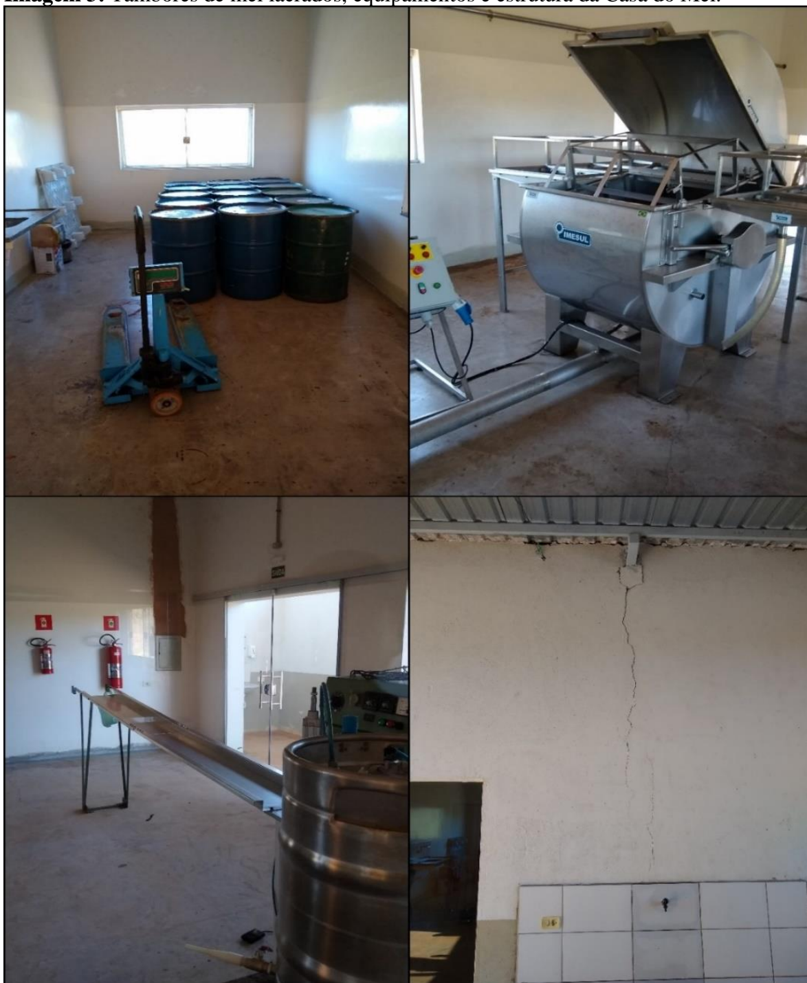
Imagem 3: Tambores de mel lacrados, equipamentos e estrutura da Casa do Mel.
