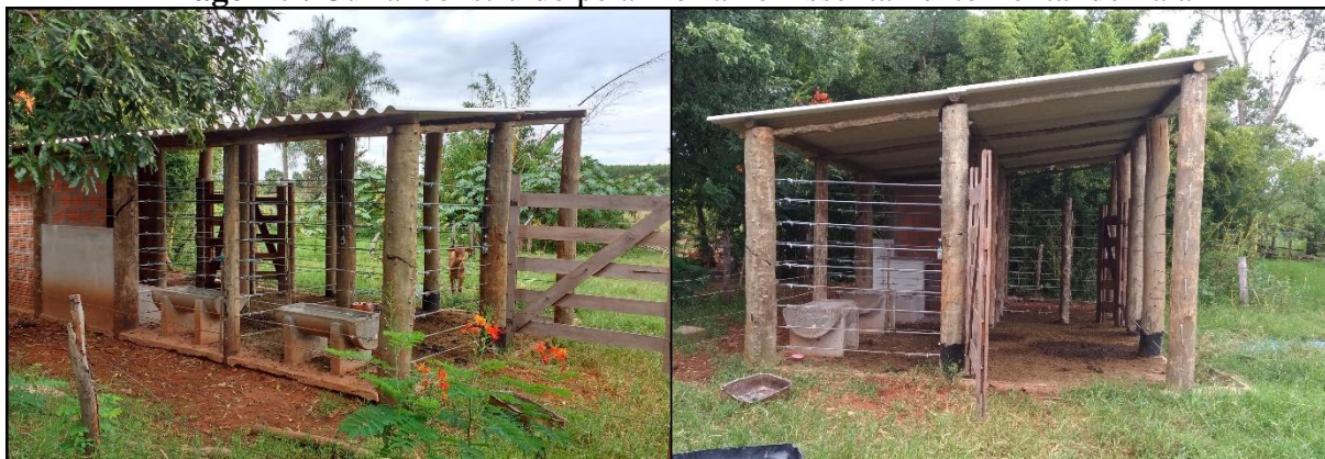
Imagem 9: Curral construído pela Fibria no Assentamento Pontal do Faia
