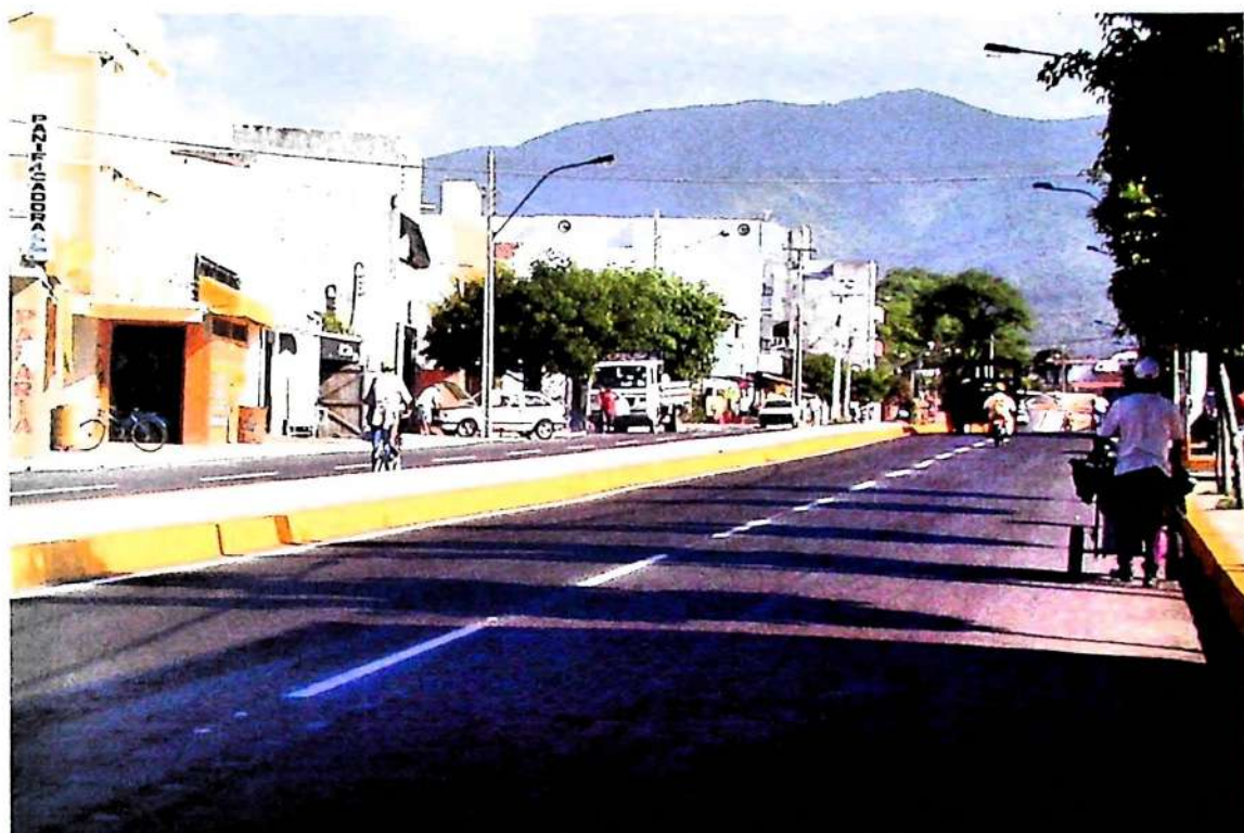
Foto 18: Sobral, Reforma e Ampliação da Av. John Sanford
