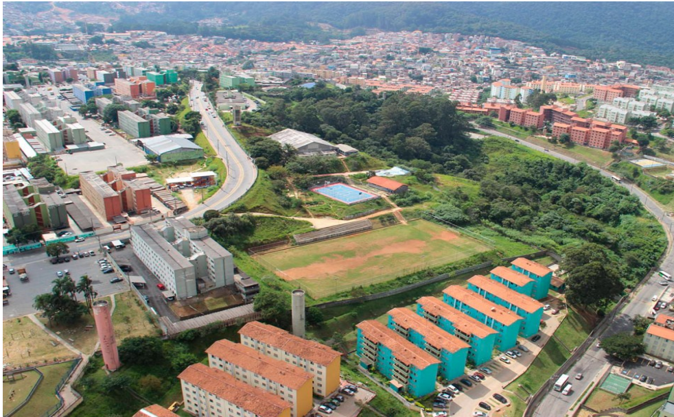
Foto 34: Terreno utilizado para construção do CEU Taipas, aproveitando-se as estruturas do Centro Esportivo Brigadeiro Eduardo Gomes . Fonte: Prefeitura de SP - Gestão Urbana/ 2016
