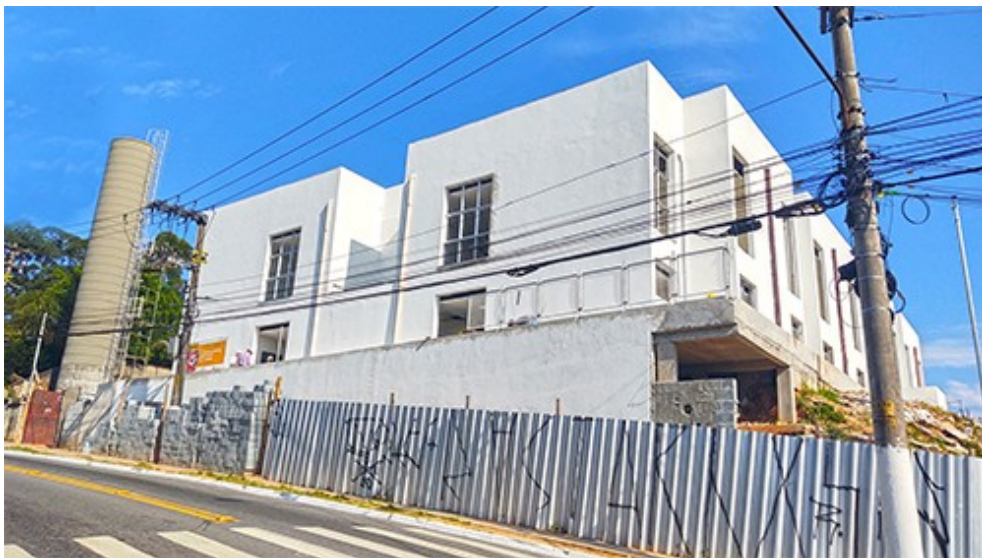
Foto 35: Obras prestes a serem finalizadas. Fonte: Prefeitura de SP - Fevereiro/ 2021
