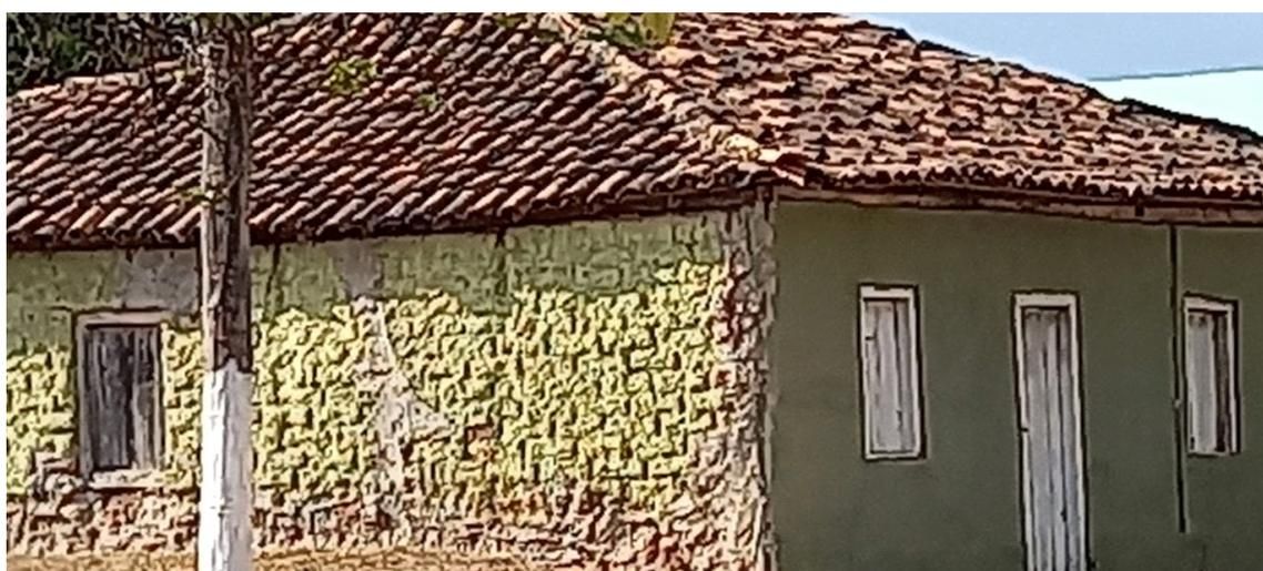
Figura 29: Antiga residência construída em adobe no Centro de Sitio d'Abadia.
