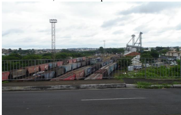
Figura 31. Ponte da Avenida Sebastião Gonçalves de Souza, na travessia para a zona Norte.
