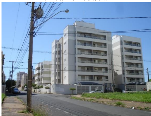
Figura 78. Quarteirão nos arredores da Avenida Romeu Strazzi.
