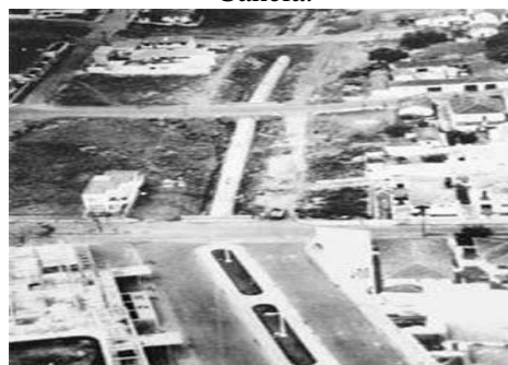
Figura 4. Canalização do Córrego Canela.
