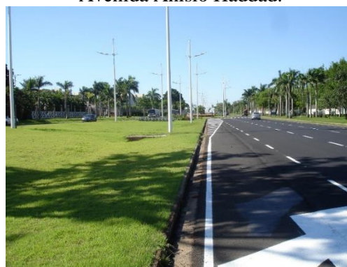
Figura 62. Canteiro central na Avenida Anísio Haddad.
