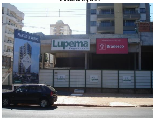
Figura 77. Edifício residencial em construção.
