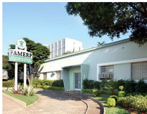
Figura 51. Fachada da Faculdade de Medicina de São José do Rio Preto.
