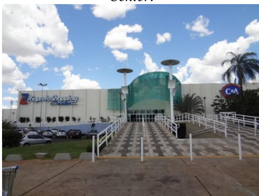
Figura 55. Fachada do Riopreto Shopping Center .
