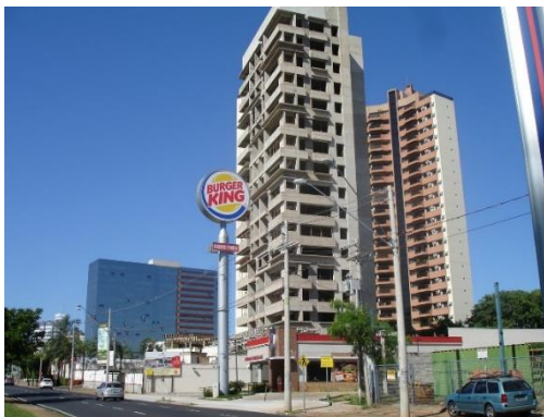
Figura 73. Edifício em construção na Avenida José Munia.
