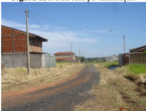
Figura 120. Rua sem pavimentação.
