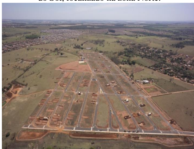
Figura 41. Imagem aérea do Residencial Morada do Sol, localizado na zona Norte.
