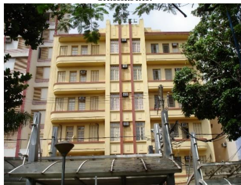
Figura 11. Edifício Caramuru, atual Hotel Itamarati.
