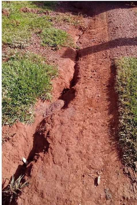
Figura 27: Exemplo de erosão em sulcos presente em toda as estradas de terra
