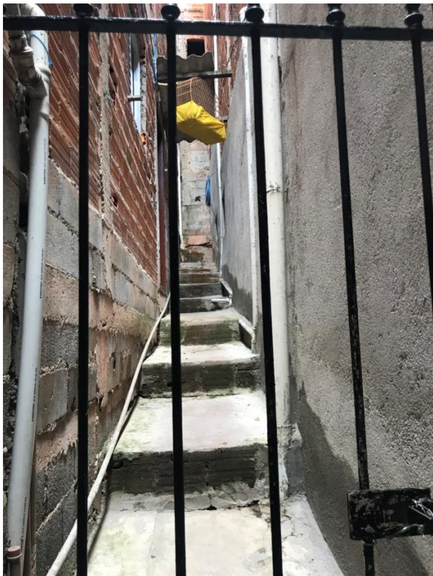
Figura 15 - Corredor de acesso à Casa 1.
