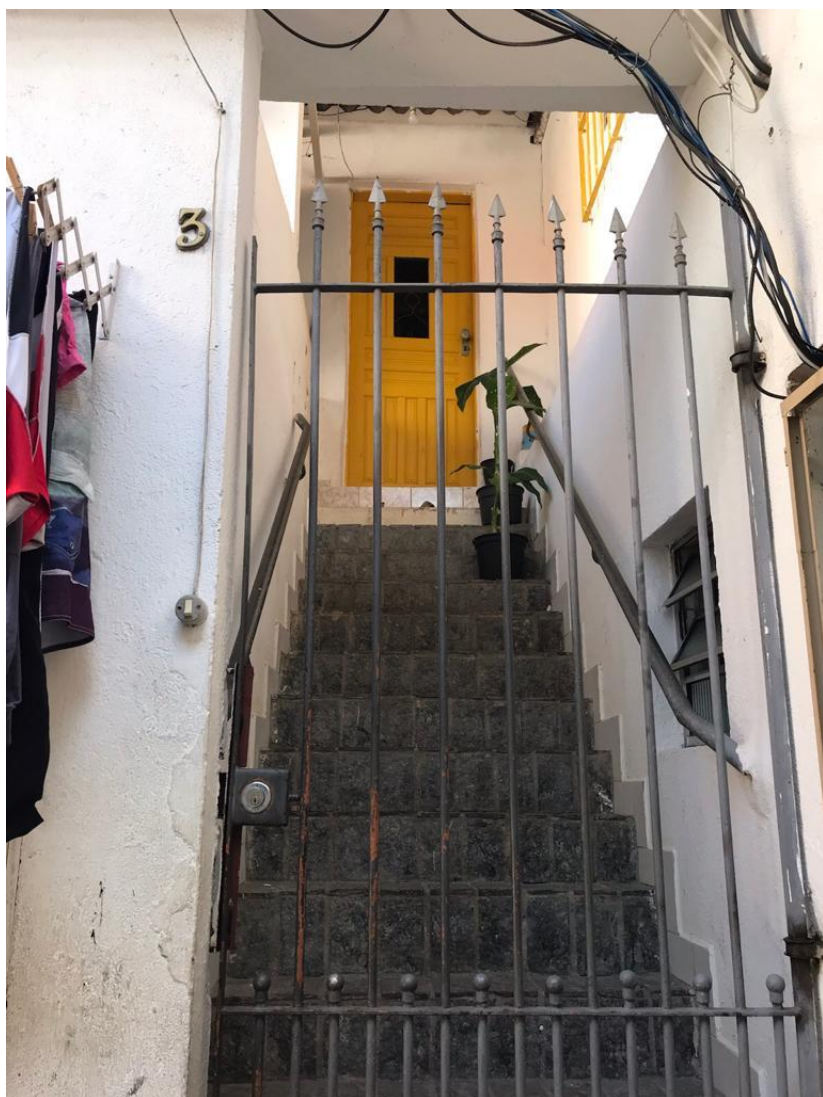
Figura 25 - Portão de entrada da casa 3.
