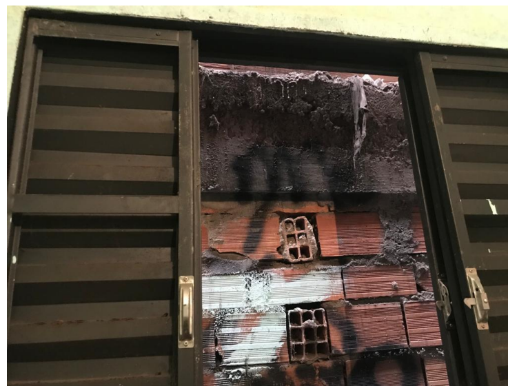
Figura 22- Vista da única janela presente na casa 2.
