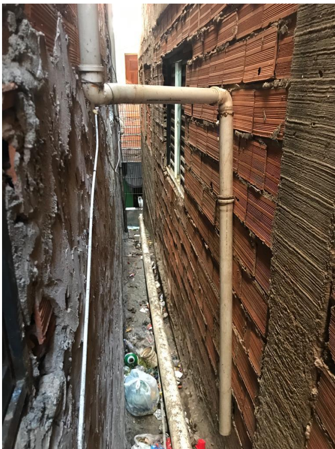
Figura 21- Vão existente entre a edificação da Casa 2 e a edificação vizinha.
