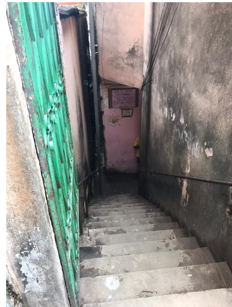
Figura 23 - Entrada do edifício em que se localiza a casa 2.
