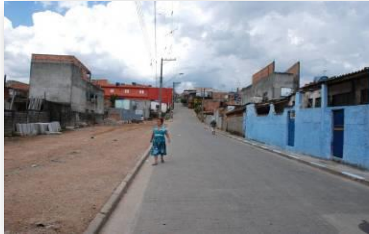
Figura 61 - Foto da rua Pernambuco após a implantação da infraestrutura viária, mas com a área reservada para implantação da praça
