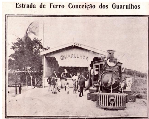
Figura 16 - A Estação Guarulhos em fevereiro de 1915, quando inaugurada
