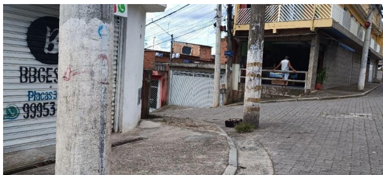
Figura 145 – Foto do poste instalado no arruamento podendo causar acidentes
