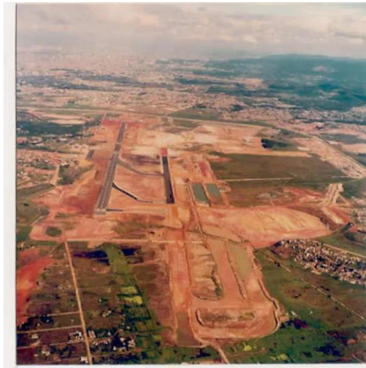
Figura 25 – Obras de terraplanagem no ano de 1980 para construção do Aeroporto de São Paulo
