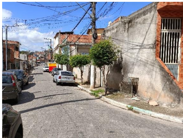
Figura 143 - Foto da calçada estreita e com passeio reduzido em decorrência da arborização na rua Santana
