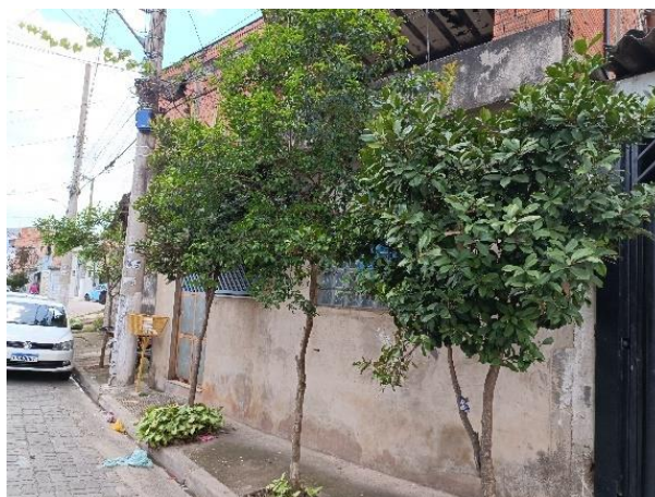
Figura 141 - Foto da calçada estreita e com passeio reduzido em decorrência da arborização na rua Maranhão
