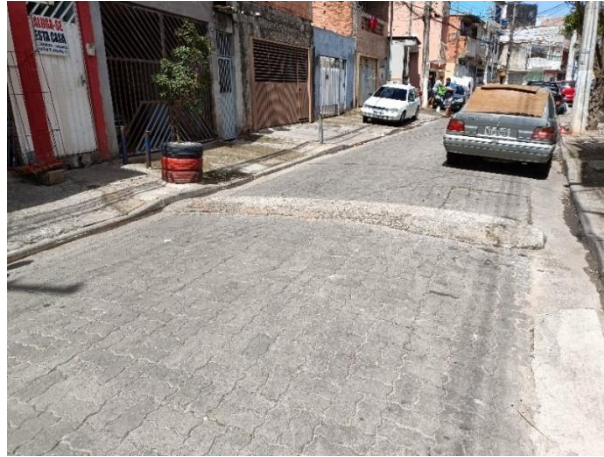
Figura 138 - Foto da lombada não seguindo nenhuma norma realizada pelos moradores na Rua Maranhão
