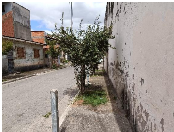
Figura 140 – Foto da calçada estreita e com passeio reduzido em decorrência da arborização na rua Paraíba
