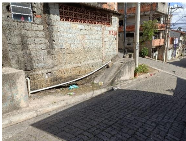
Figura 131 - Foto das autoconstruções na calçada
