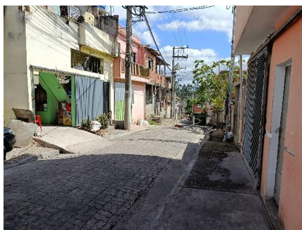
Figura 144 - Foto da calçada estreita e com passeio reduzido em decorrência da arborização na rua Santana
