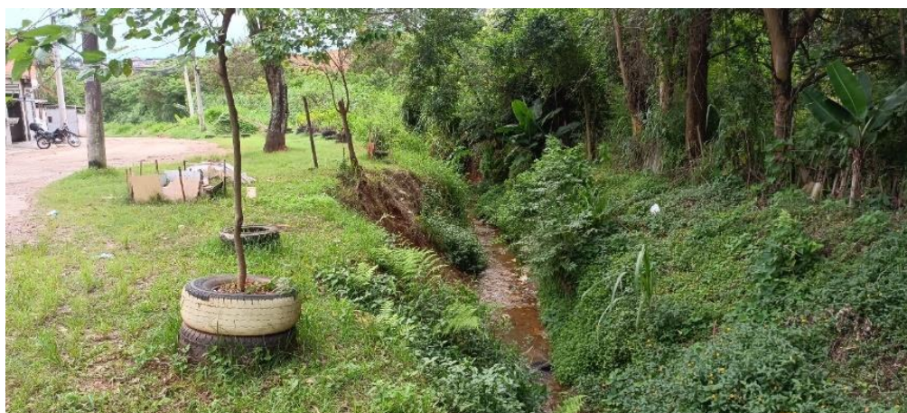
Figura 151 - Foto mostrando a proximidade do arruamento com o corpo d'água sem nenhuma barreira podendo ocorrer acidentes
