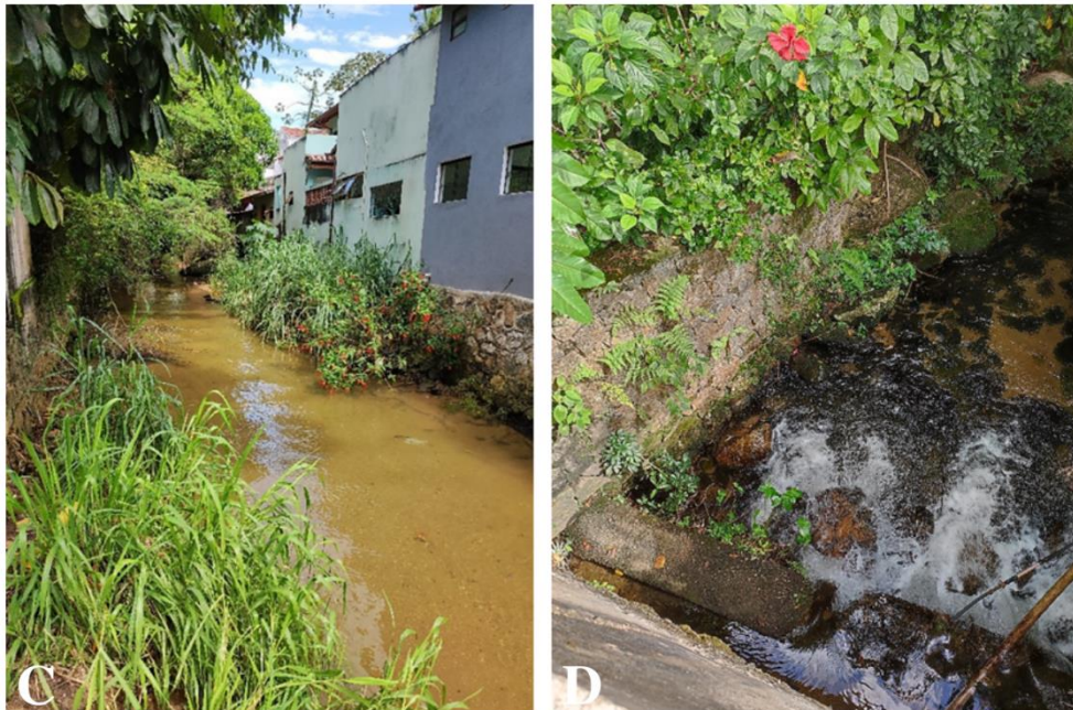
Figura 49 – Exemplo de alterações no canal em condição péssima (severamente degradado), observado em trechos de baixo curso na área urbana, sendo que C e D apresentam canal modificado por margens artificiais
