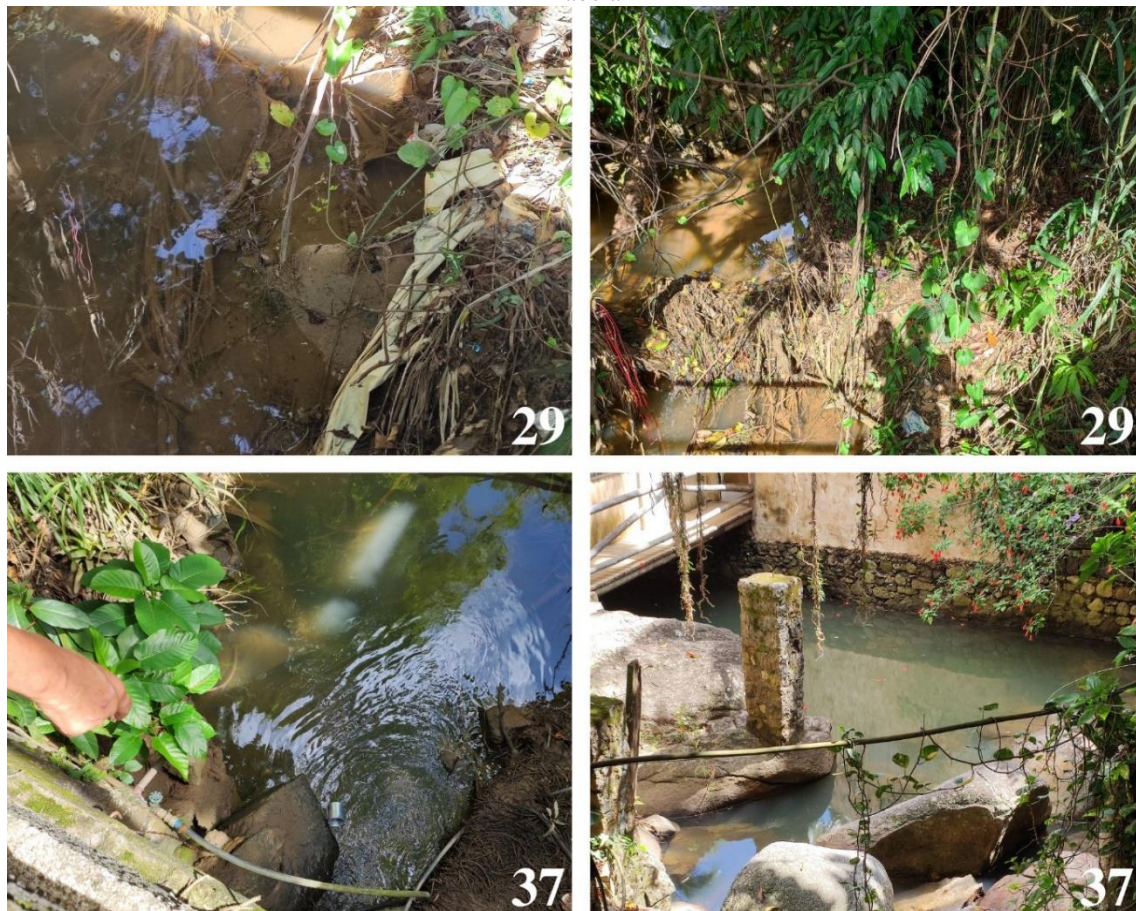
Figura 73 – Aspectos dos trechos classificados como situação “péssima” no setor sul da área urbana pelo PAR Ilhabela
