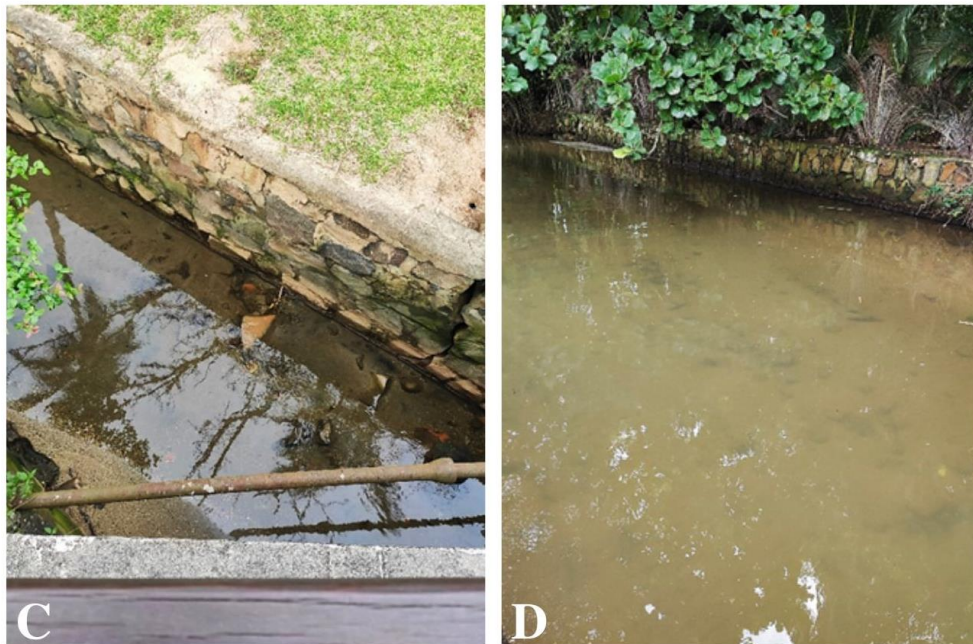
Figura 33 – Exemplo de tipos de fundo em condição péssima (severamente degradado) em área urbana, sendo que nas imagens C e D nota-se fundo coberto por lama e areia em diferentes trechos avaliados
