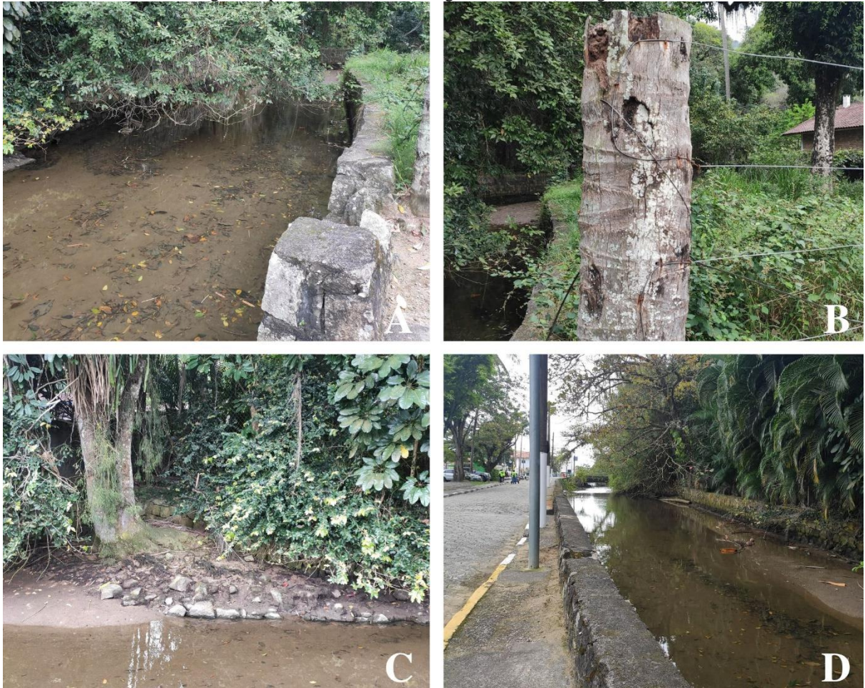
Figura 16 – Ponto 5, Córrego Cachoeira, no Centro Histórico da ilha – A) Deposição de sedimentos; B) Entorno da margem esquerda; C) Parte da margem direita; D) Margens artificiais
