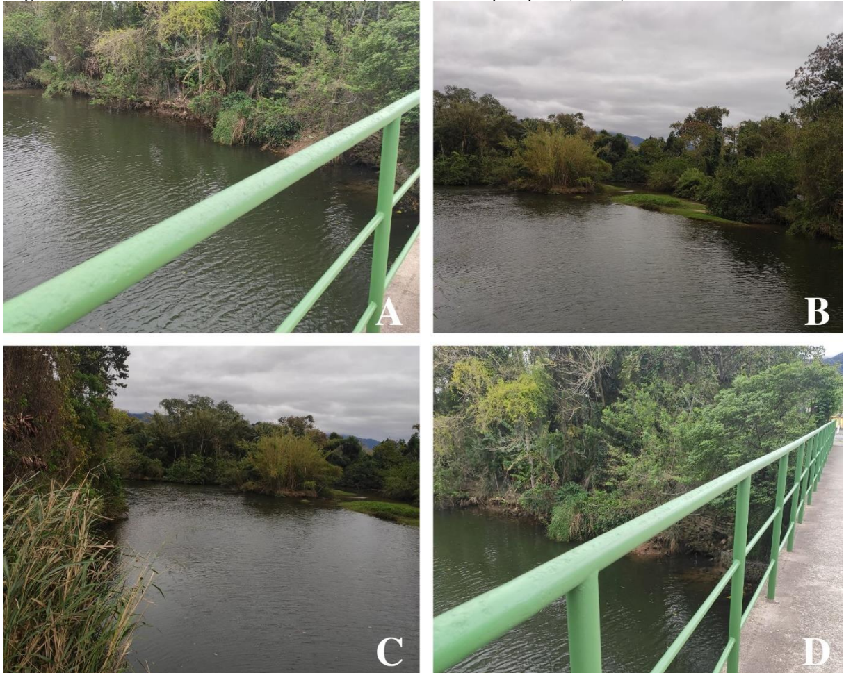
Figura 22 – Ponto 11, Córrego Paquera – A e D) Vista do trecho pela ponte; B e C) Mata ciliar e banco de areia
