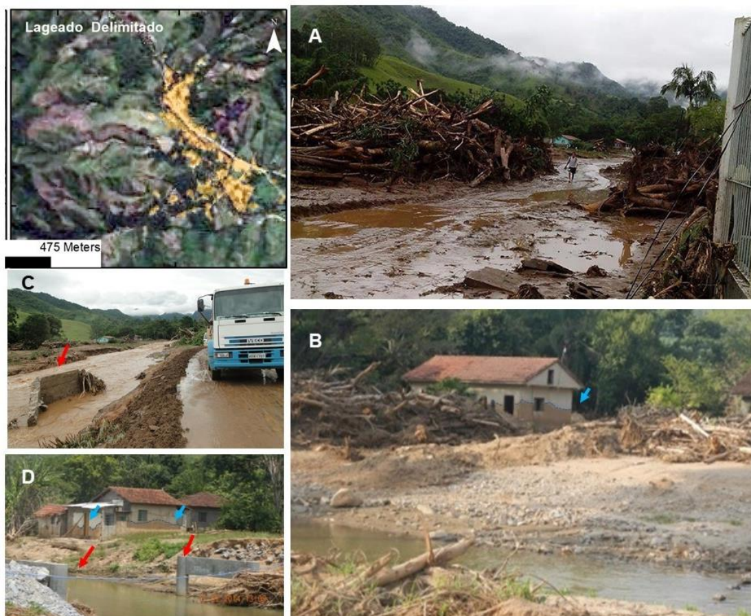
Figura 20: Em (A) e (B) observa-se o aspecto das inundações bruscas neste bairro. Em (C) e (D) destaca-se, respectivamente, a destruição da ponte na paisagem ainda recoberta por detritos e a construção da nova ponte. Fonte: A1: Google Earth, imagens históricas (agosto, 2014). Fotografias (A) e (C) Prefeitura do município de Itaoca/Acervo, 2014; (B) e (D) Picanço/UNICAMP, 2014.
