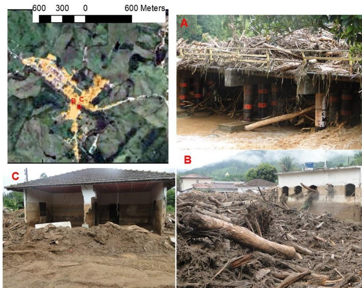
Figura 21: Impacto das inundações no centro da cidade de Itaoca. Em (A) observa-se a obstrução da ponte central principalmente por detrito vegetal e lama. Em (B) nota-se a altura a que o rio subiu depositando o material flutuante nas casas e construções próximas. Em (C) percebe-se a força da água e material transportado através do dano à estrutura construtiva. Fonte: Google Earth, imagens históricas (agosto, 2014). Fotografias: Prefeitura do município de Itaoca/Acervo, 2014.
