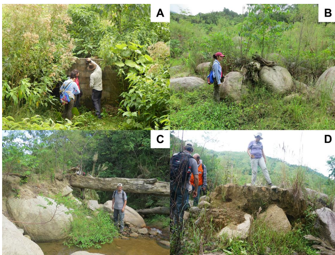
Figura 14: Observações realizadas em trabalho de campo na bacia do Rio Guarda-Mão em abril de 2017. (A) medição da altura da casa soterrada; (B) observação de blocos de tamanhos intermediários. (C) barramento natural ao longo do curso principal e (d) depósito de corridas de detritos de 2014.
