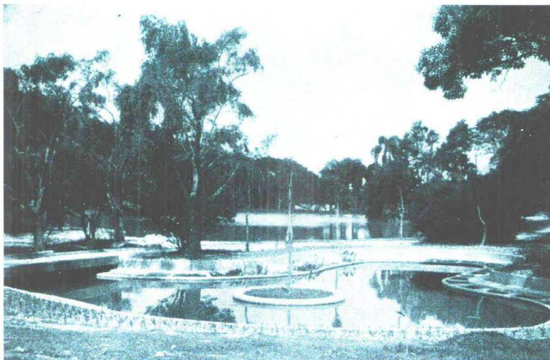
Figura 73: Hidrofitotério recém concluído em 1947 (Hoehne, 1949a)
