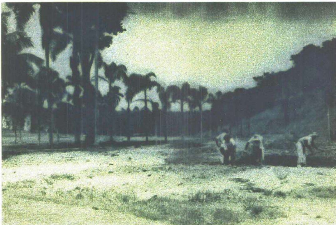
Figura 38: Final da Alameda Fernando Costa em término de obras em 1947 (Hoehne, 1949a)
