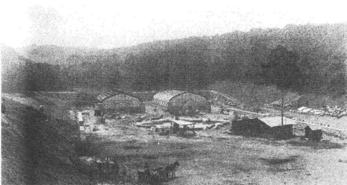
Figura 48: Estufas e Jardim de Lineu em construção em 1928 (Milanez, 1997)
