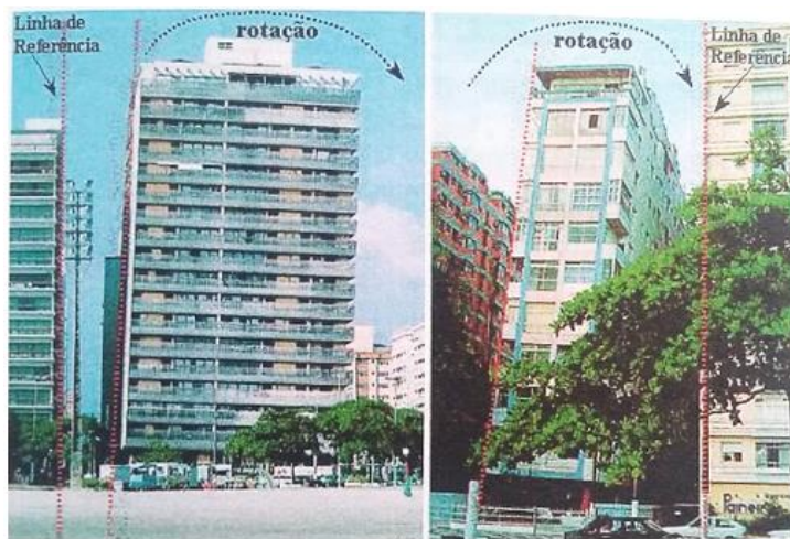
Figura-Apêndice 4 - Exemplo de recalque em edifícios na cidade de Santos - SP
