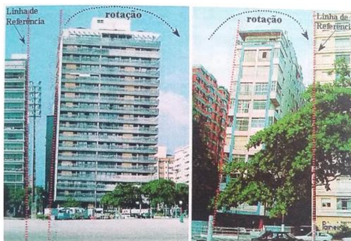
Figura 44 - Exemplo de recalque em edifícios na cidade de Santos - SP
