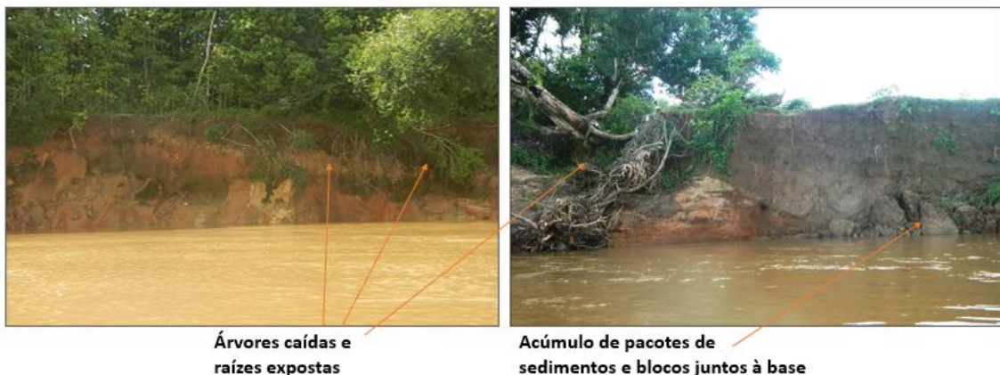
Figura-Apêndice 8 - Exemplos de solapamento em margem côncava de canal fluvial, em dois trechos do rio Ribeira de Iguape
