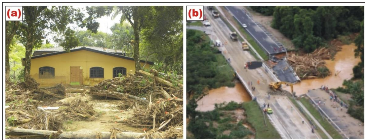
Figura 3.12: Moradia atingida pelas corridas de detritos, com deposição de materiais finos e lenhosos (a); ponte sobre o rio Jacareí parcialmente destruída em Rodovia que liga Curitiba ao litoral (b).
