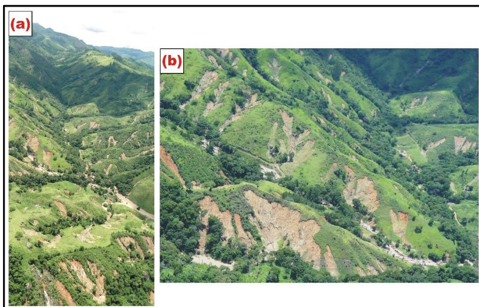
Figura 3.28: Bacia Gurutuba. Grande quantidade de escorregamentos nas encostas (a) . Detalhe para o tamanho das cicatrizes de escorregamentos (b) .
