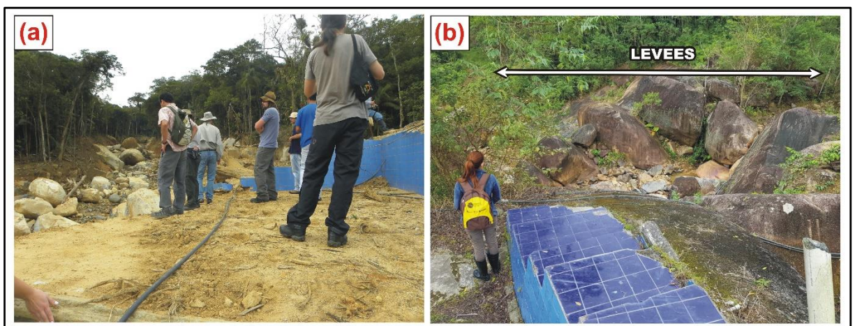
Figura 4.19: Piscina parcialmente destruída em moradia localizada no alto da encosta, na margem esquerda do rio, no P5. (a): imagem de 2011, logo após o evento, com sedimentos finos ainda presentes, indicando a altura do fluxo. (b): imagem recente da mesma área, já sem sedimentos finos e com canal e vale mais profundo, em comparação à época do evento.
