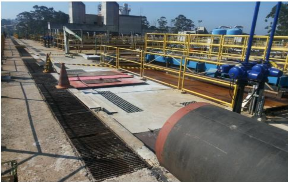
Figura 31 - Melhorias na estrutura de bombeamento do Sistema Rio Grande em 2014.
