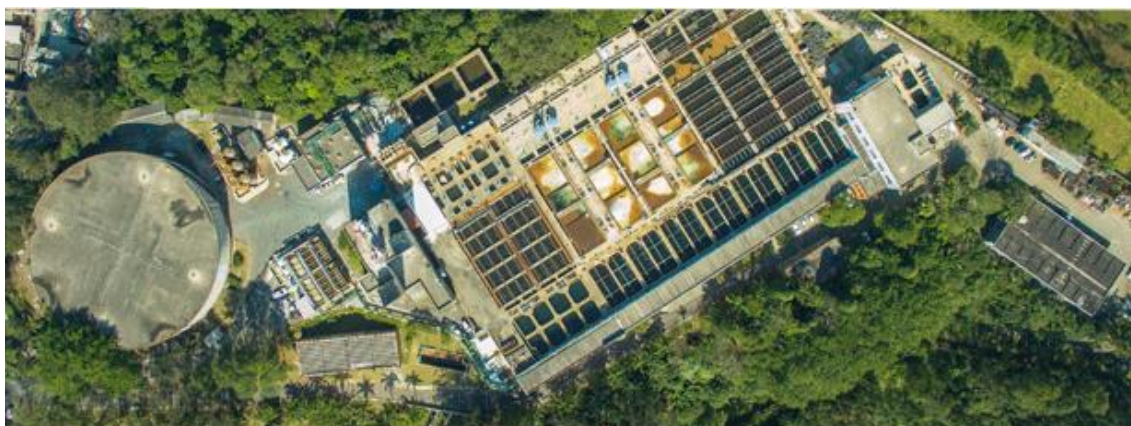
Figura 11 - Sistema Rio Grande Fonte: Sabesp (2022). Adaptação do Autor.
