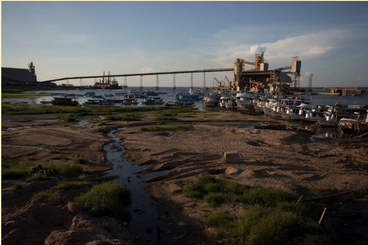
Figura 32. Porto de exportação de soja da Cargill no centro da cidade de Santarém. Foto de Bruno Kelly (Le Monde Diplomatique Brasil/Pulitzer Center).
