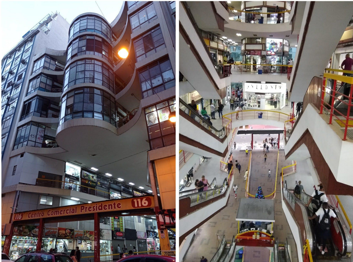
Imagem da fachada da Galeria do Reggae e do seu interior visto do terceiro andar. Foto minha
