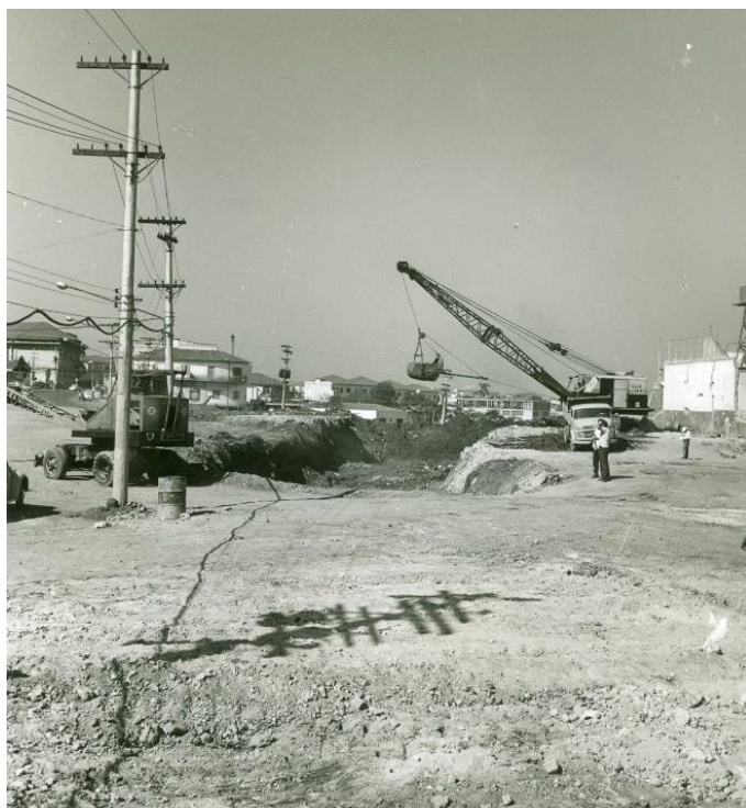
Figura 21. Construção do Terminal Rodoferroviário Jabaquara Acervo: Biblioteca do Metrô de São Paulo
