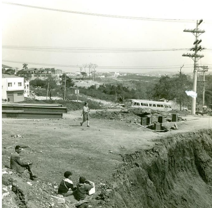
Figura 19. Área de construção do Terminal Rodoferroviário Jabaquara. Acervo: Biblioteca do Metrô de São Paulo.
