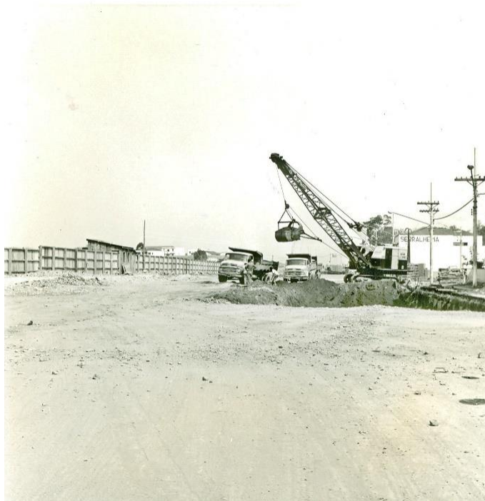
Figura 20. Construção do Terminal Rodoferroviário Jabaquara Acervo: Biblioteca do Metrô de São Paulo
