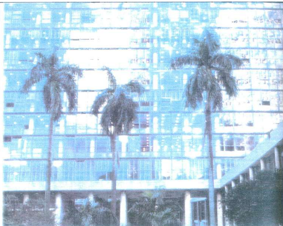
FIGURA 3.15 Os pilotis da lâmina principal (vista do lado sul) alinham-se aos "falsos" pilotis do anexo do salão de exposições MESP (1936). (Costa, 1995:124)
