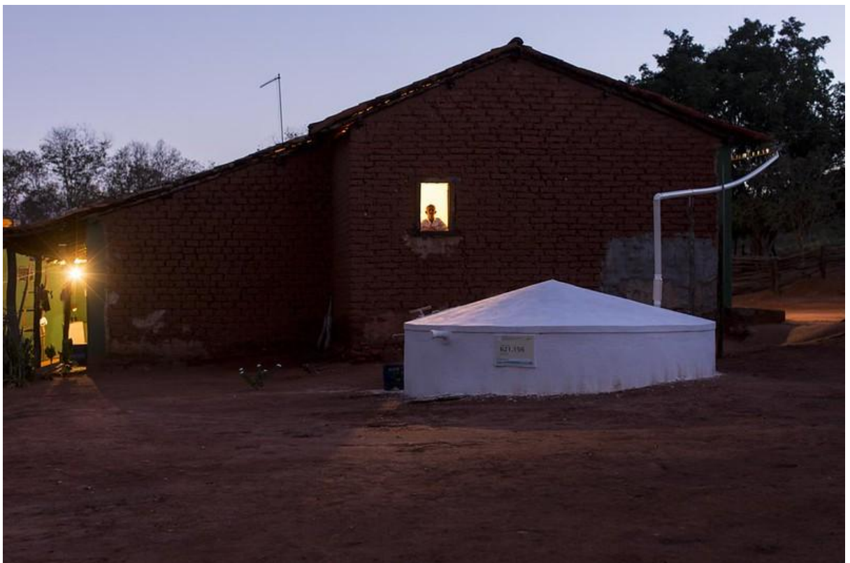
Figura 7: cisterna doméstica instalada na comunidade da Caicara, MG (ASA, 2021b)
