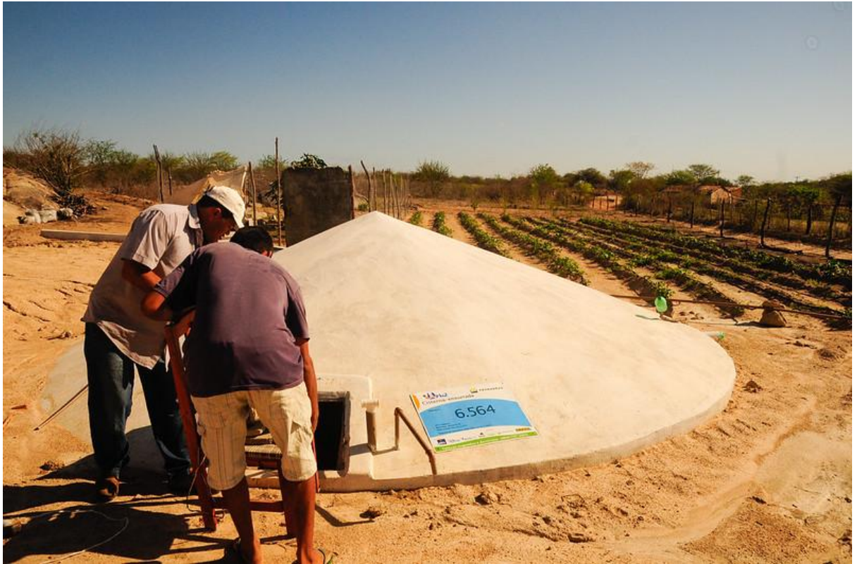
Figura 9: Cisterna barrageira, de produção. ASA (2021b)
