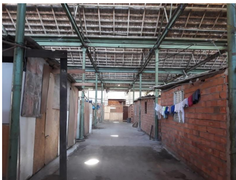
Figura 2 – Casas de alvenaria de migrantes haitianos e casas de brasileiros de madeirite na ocupação da antiga Fábrica de Tecidos Labor na Mooca.
