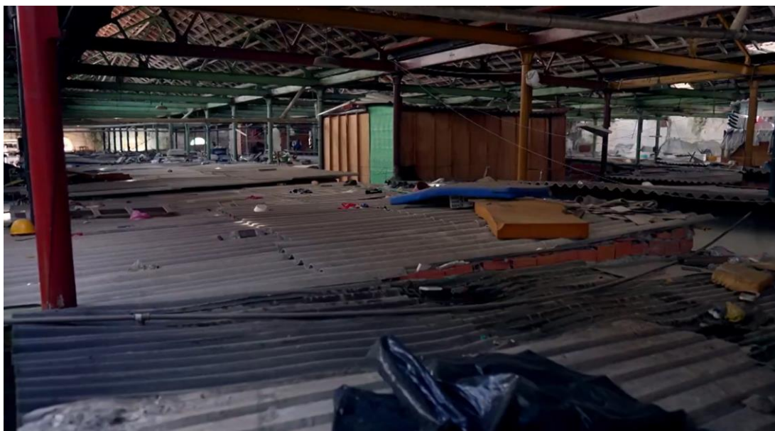
Figura 3 – Telhados das casas na ocupação da antiga fábrica de Tecidos Labor na Mooca.
