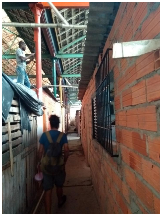
Figura 1 – Casa de alvenaria de migrante haitiano na ocupação da antiga Fábrica de Tecidos Labor na Mooca. Em detalhe, a grade de proteção na janela.
