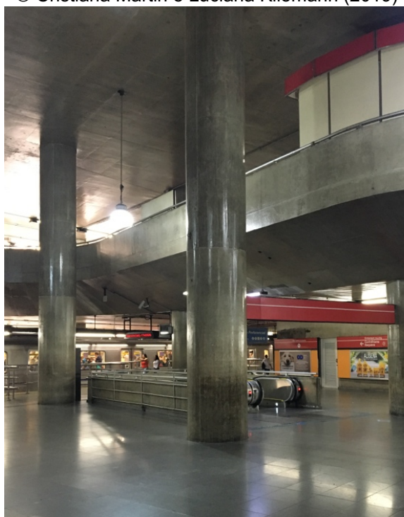
Figura 3: Sobreposição do mezanino no pavimento da Linha Vermelha, na plataforma de embarque para Corinthians/Itaquera © Cristiana Martin (dezembro/2017)
