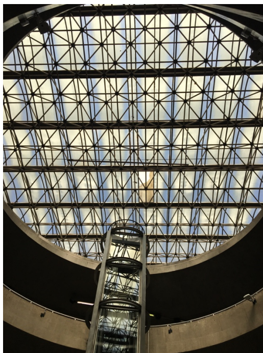
Figura 9: Claraboia vista do pavimento da Linha Azul, o mais profundo da estação © Cristiana Martin (janeiro/2018)
