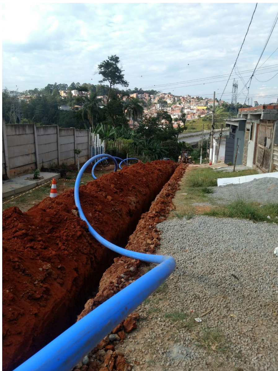
Figura 27 – Obras do Programa Água Legal da Sabesp no Jardim Milão em maio de 2022
