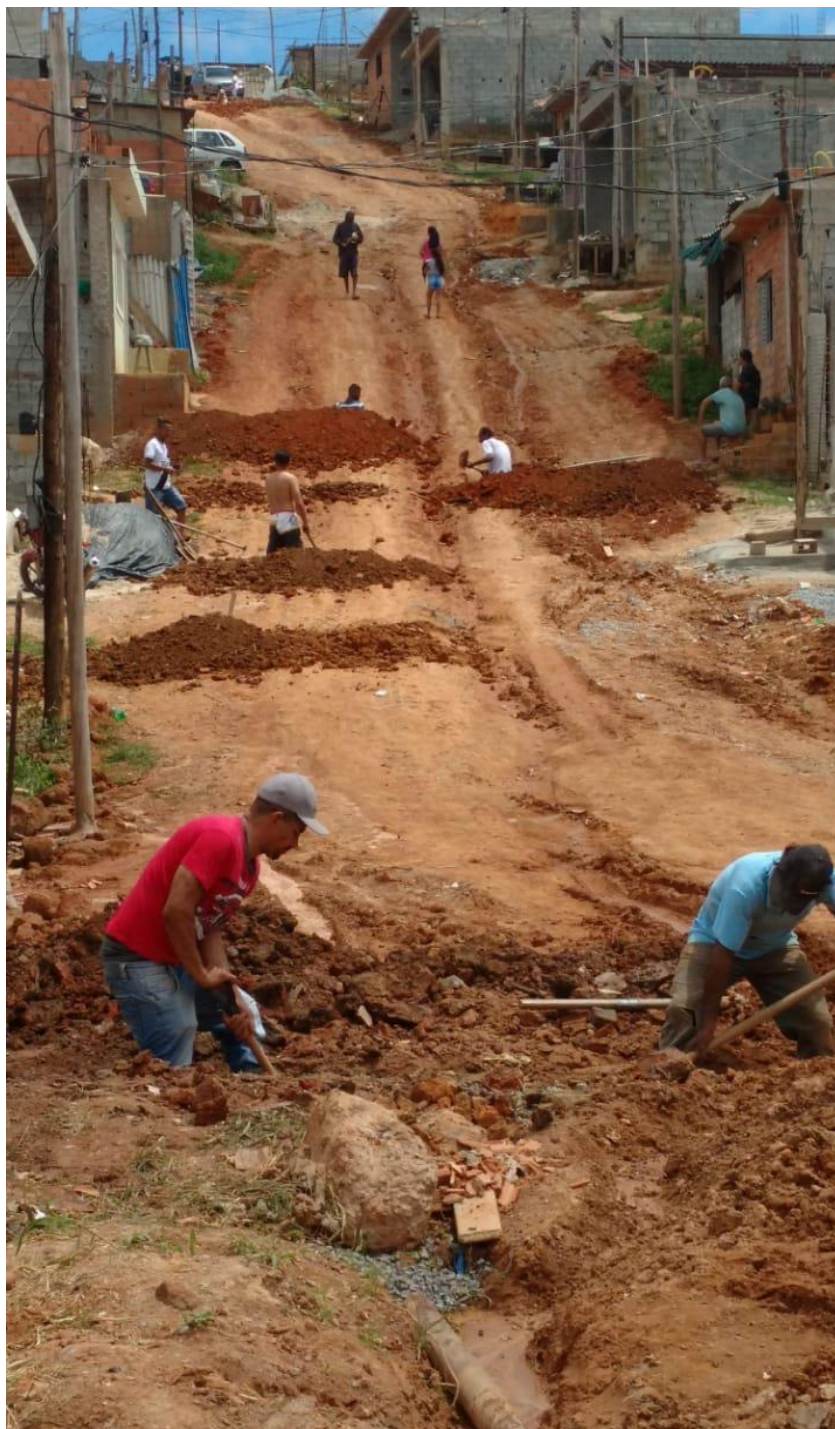
Figura 28 – Homens trabalham nas ligações das casas à rede de esgoto em novembro de 2018
