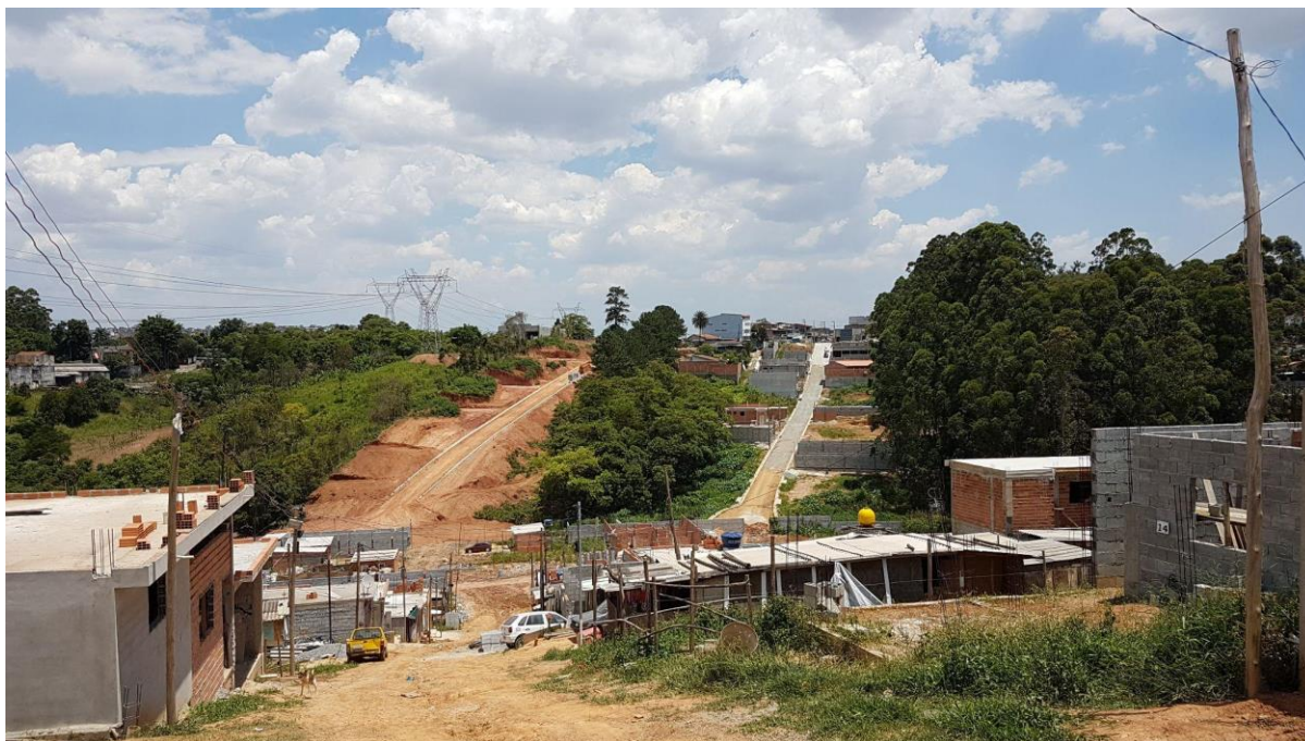
Figura 17 - Abertura da segunda rua, vista da ocupação
