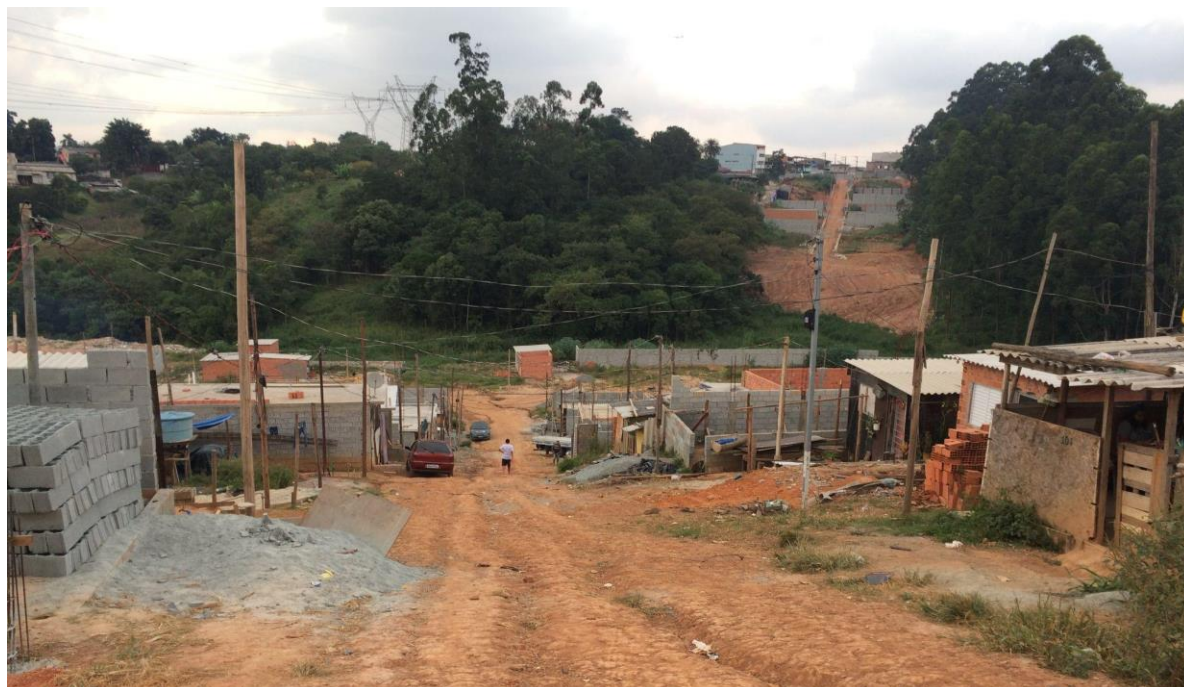
Figura 16 - Abertura da primeira rua do loteamento, vista da ocupação
