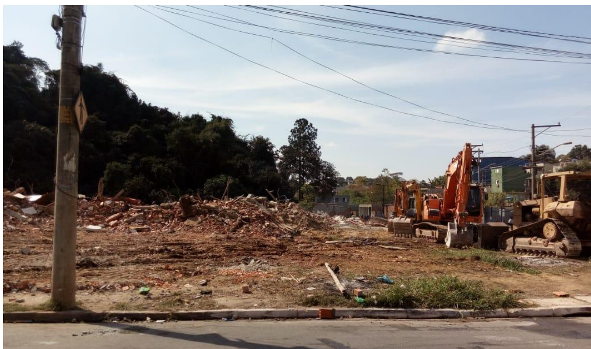
Imagem 37 – Fim da remoção da ocupação Orquídea
