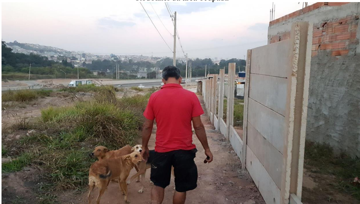
Figura 9 - Muro sendo construído pela DERSA separando em definitivo a faixa de domínio do Rodoanel da área ocupada
