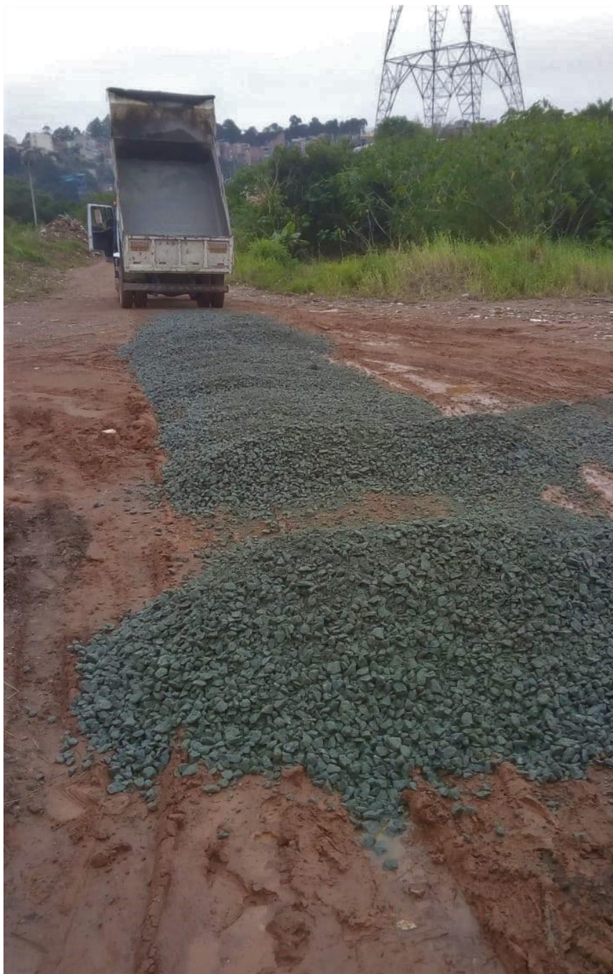
Figura 25 – Despejo de britas nas ruas
