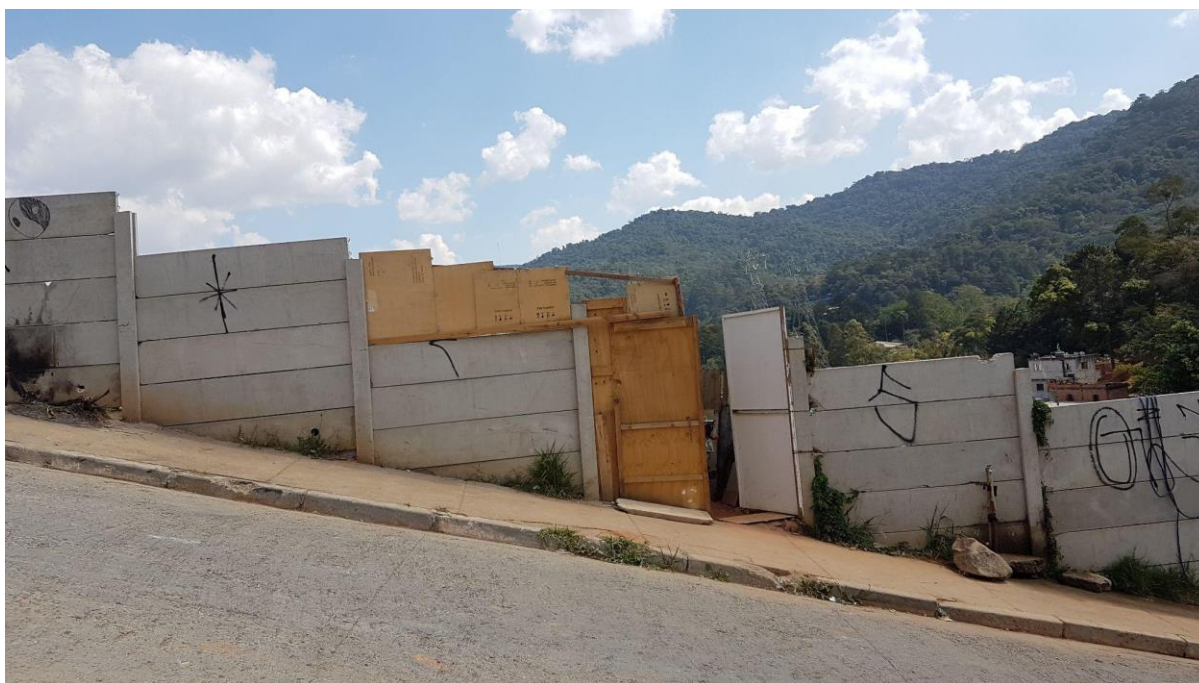
Figura 19 - Entrada da ocupação improvisada no muro construído pelo Rodoanel
