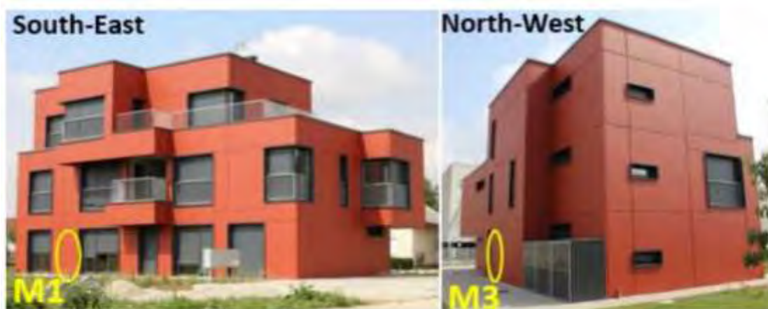
Figura 2.2 - Aplicação do painel em escala real em casa unifamiliar
