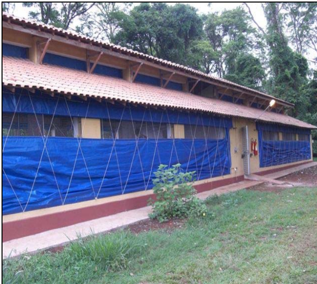
Figura 4: Vista externa do galpão
