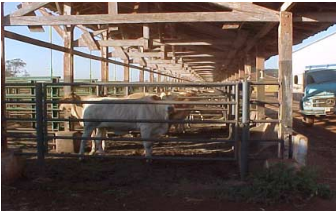
Figura 1 – Vista das instalações do confinamento
